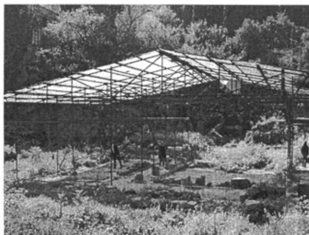
Veduta della copertura esistente
