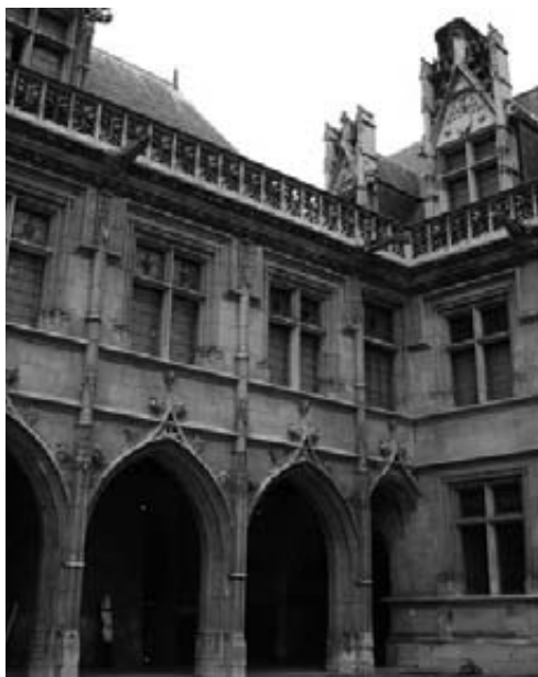
Veduta dal cortile.
