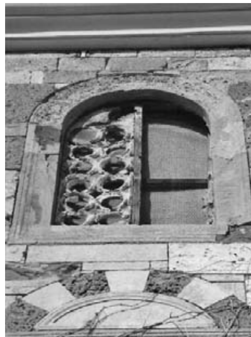
Particolare di una finestra.
