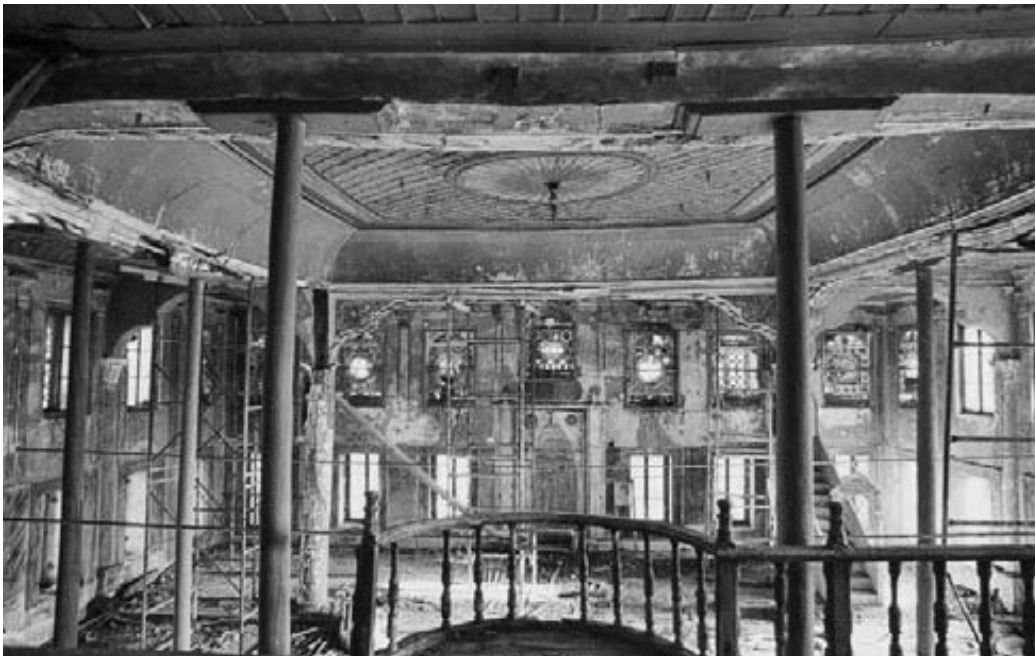
La Sala di Preghiera prima dell'intervento per la sostituzione del tetto (Archivio Vakouf Kos).
