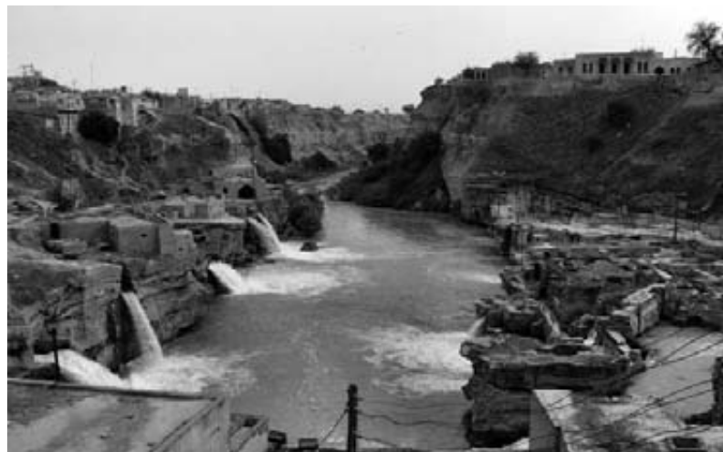
La città di Shushtar venne edificata su un complesso sistema di canali sotterranei, utilizzati per l'agricoltura, ma anche per rifornire di acqua le abitazioni private.
