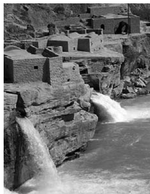
La differenza di livello tra l'insediamento e il fiume Karoun ha spinto gli abitanti di Shushtar a costruire acquedotti, per protezione dalle alluvioni e per irrigare i terreni agricoli.
