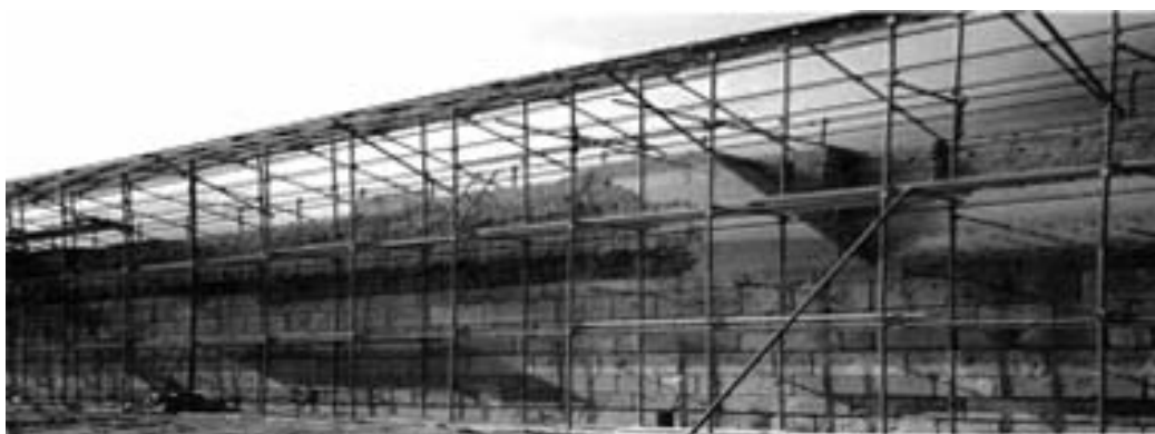
Stato attuale del muro protetto da una copertura provvisoria.
