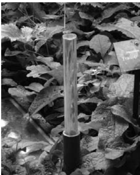
Faretto a fibre ottiche situato tra le piante del giardino.
