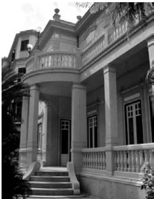
Villa Antonietta. Particolare di una finestra ante operam e portico d'ingresso dopo i lavori di restauro.
