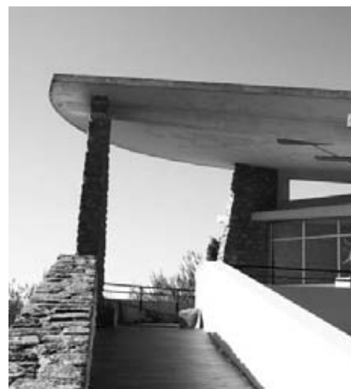
La copertura della Scuola Materna.
