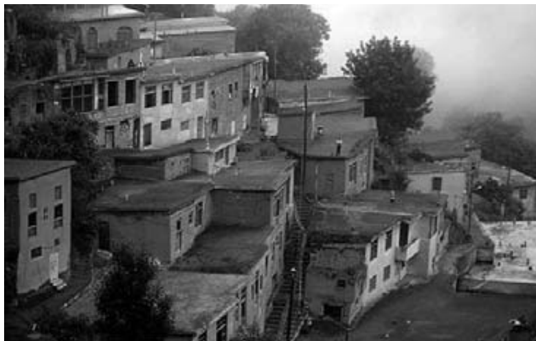
A Masouleh le abitazioni sono costruite l'una sull'altra: il tetto di una casa è la terrazza di quella sovrastante.
