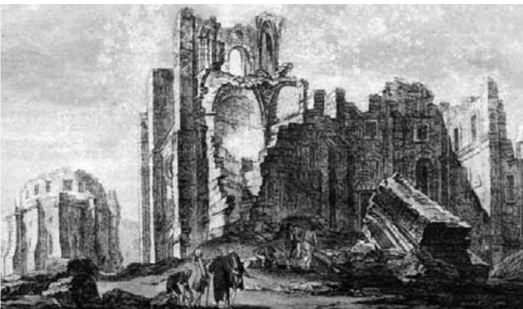
Stampa d'epoca che illustra i danni ai monumenti prodotti dal terremoto di Lisbona nel 1755.
