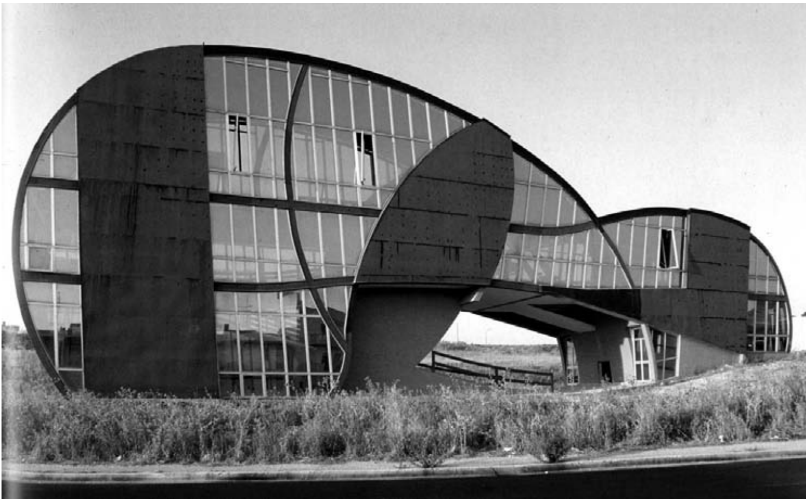
Edificio Frontale Meeting a Gibellina, in cemento armato e vetro, 1972-'83.
