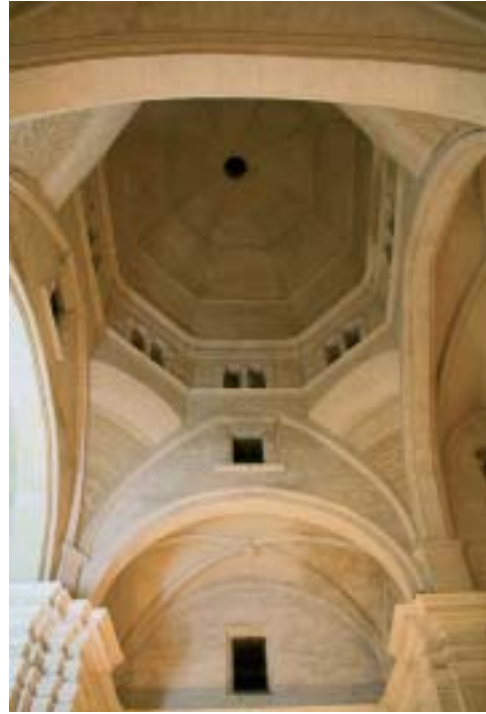
Fig. 6. Sassari. Chiesa di Gesù e Maria. Veduta del sistema di copertura sulla zona dell'incrocio.
