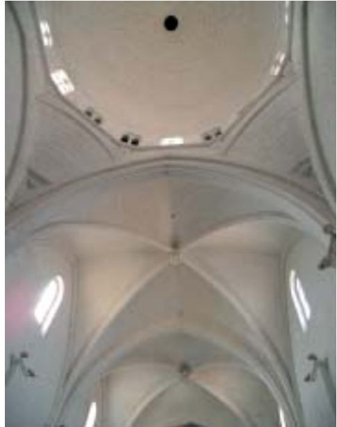
Fig. 9. Sassari. Cattedrale. Veduta del sistema voltato di copertura.
