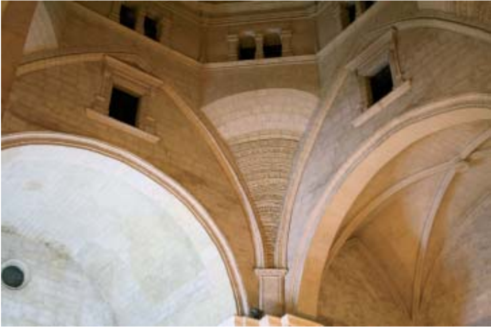
Fig. 7. Sassari. Chiesa di Gesù e Maria. Dettaglio degli archi e di un pennacchio di raccordo del sistema di copertura sulla zona dell'incrocio.
