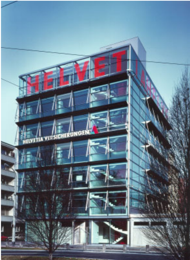
Frontansicht und Ansicht zum Grundstück hin – Tagsüber
