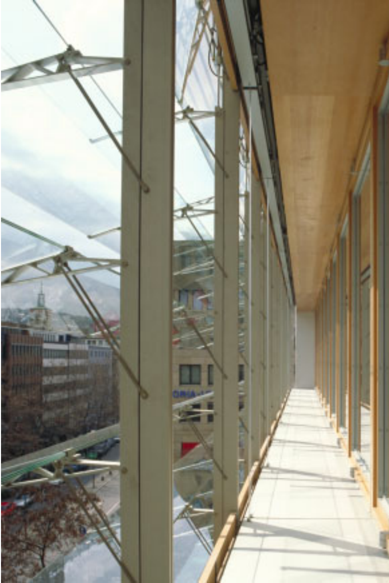
Zwischenraum von der inneren bis zur äußeren Glasebene mit offenen Lamellen
