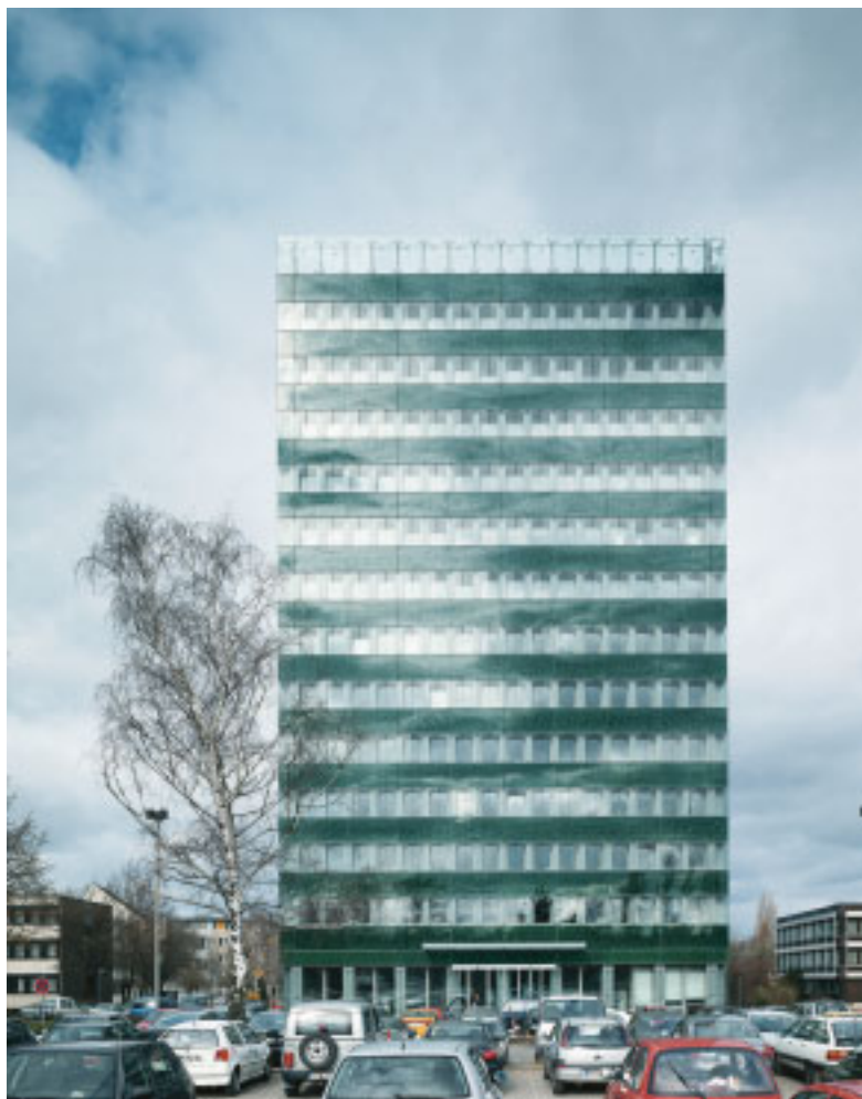
Ansicht Ost / Haupteingang
