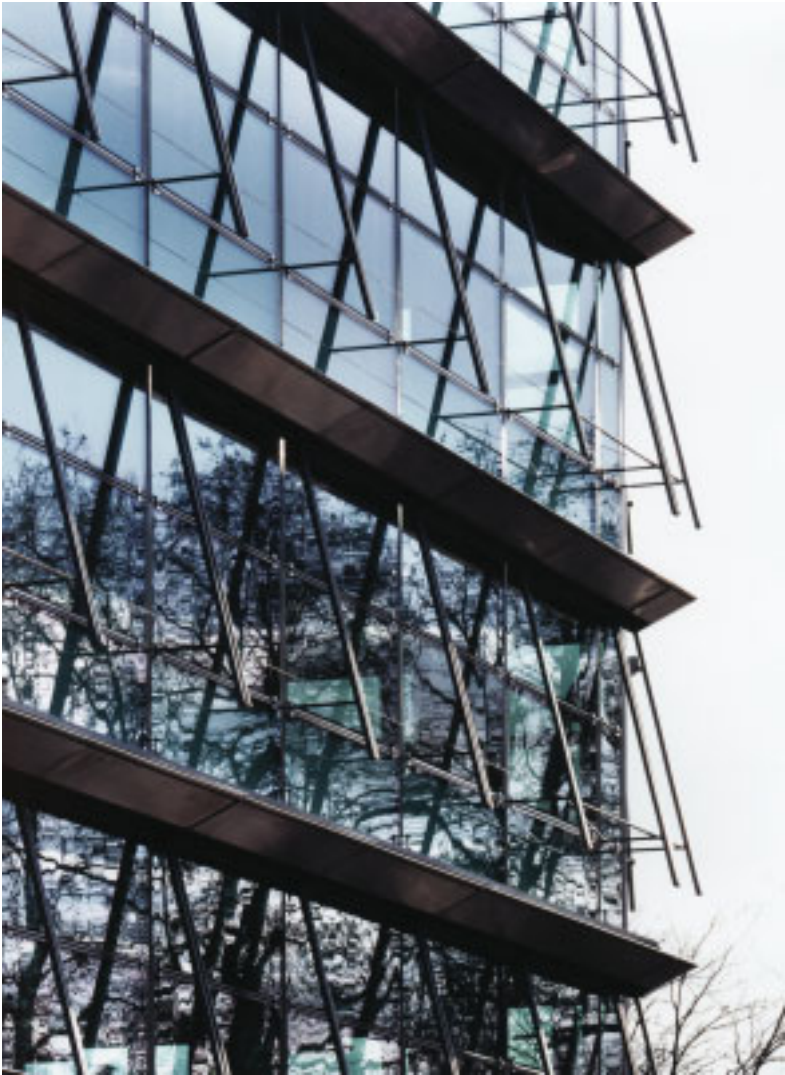
Fassadendetail – Sonnenschutzkasten und Führungsschienen
