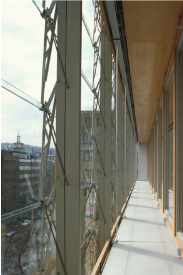
Zwischenraum von der inneren bis zur äußeren Glasebene mit geschlossenen Lamellen
