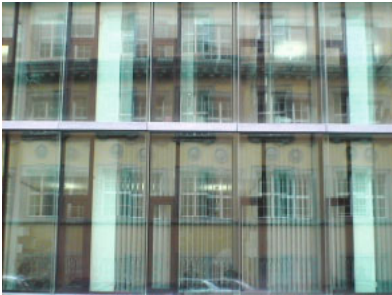
Fassadenhaut – Frontaler Ausschnitt
