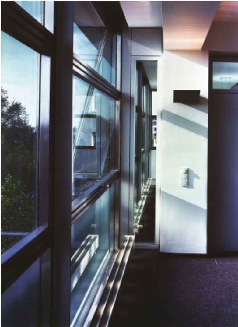
Innenraum: neue Fassade, alte Stützen und Unterzüge
