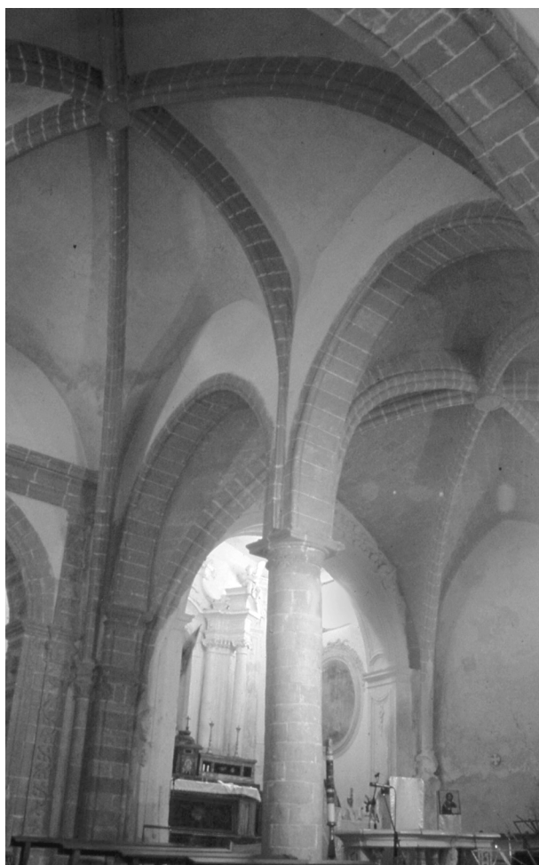
Fig. 13. Erice (Trapani). Chiesa di Sant'Orsola, particolare dell'interno.
