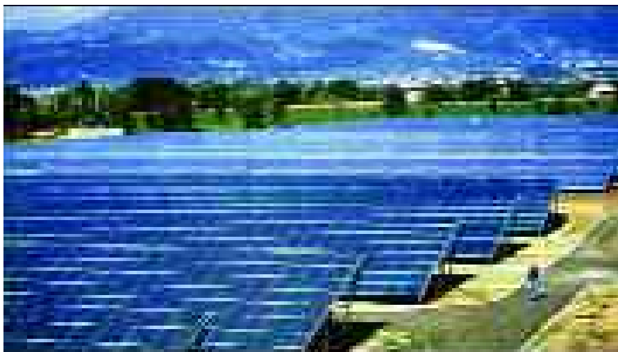
▼ Foto 2 - Veduta della centrale ENEL di Serre, da 3.300 kW ed un particolare dell'impianto ENEA Delphos da 600 kW.
