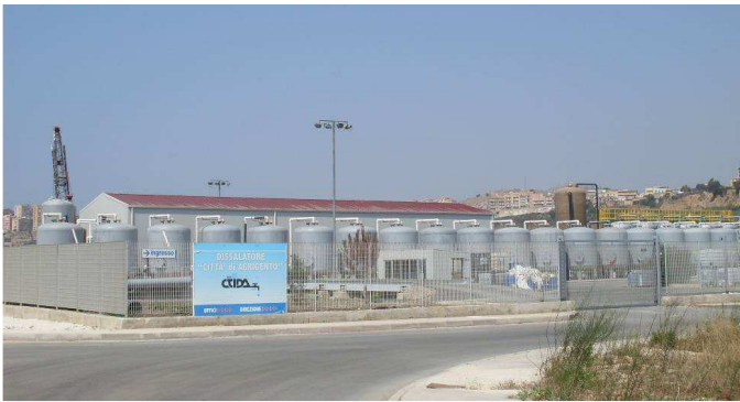
Figura 6 – Vista dell'impianto di dissalazione a OI presso Porto Empedocle (Ag)
