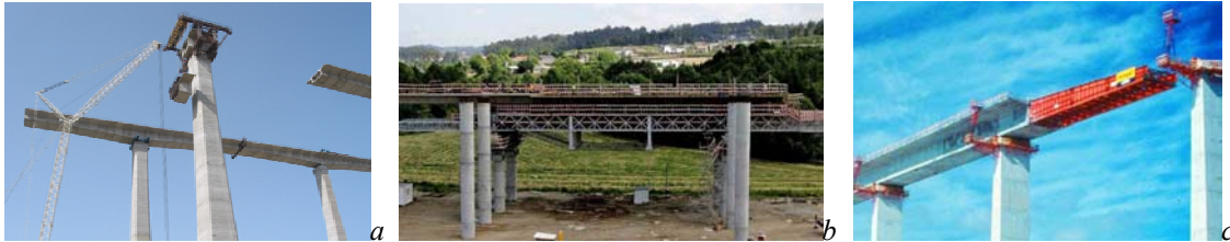
Figura 1: Metodologie di costruzione: a) per sbalzi successivi ; b) con centina mobile ; c) a spinta.
