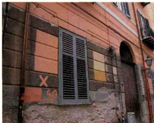
In alto: Palermo, palazzo ad angolo tra viale della Libertà e via F. P. Di Blasi. Particolare della parte basamentale dove sono stati approntati i provini di colore. La nuova vernice, ricoprendo la superficie in maniera uniforme annulla l'effetto "finta pietra" che era stato ottenuto con l'uso di inerti di varia granulometria.
