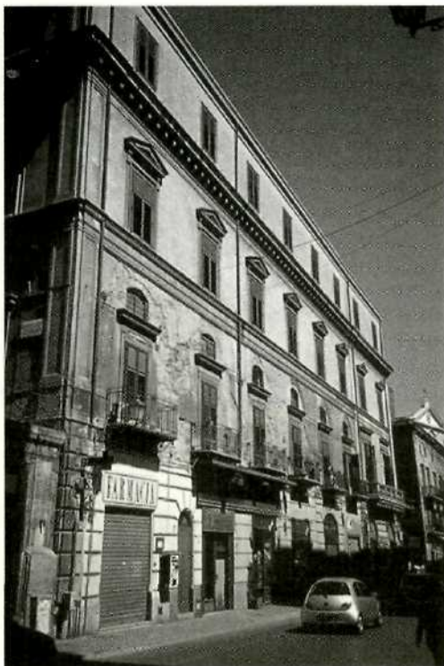
Palermo, facciata su via Maqueda della vecchia sede della Facoltà di Architettura. La foto di tre anni addietro mette in evidenza l'impiego di finiture in pietra artificiale con fondi che imitano una cortina di mattoni rassi. In una limitata porzione del primo piano è visibile una circoscritta mancanza.
