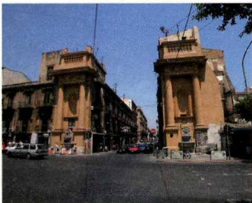
In alto: Palermo, porta di Vicari realizzata nel 1789 come testata della via Maqueda dal lato orientale. Assecondando gli indirizzi del piano particolareggiato per il recupero del centro storico le superfici sono state recentemente dipinte con un colore che tenta invano di imitare il tono dei materiali lapidei del progetto neoclassico.
