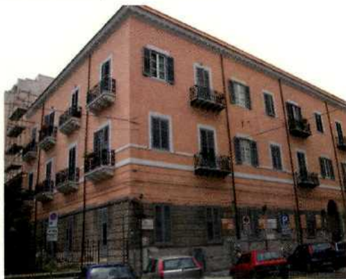
In basso: Palermo, palazzo ad angolo tra viale della Libertà e via F. P. Di Blasi. Il palazzo costruito nei primi anni del Novecento era decorato con un intonaco a imitazione di un paramento lapideo di calcarenite che, anziché essere pulito, è stato verniciato.
