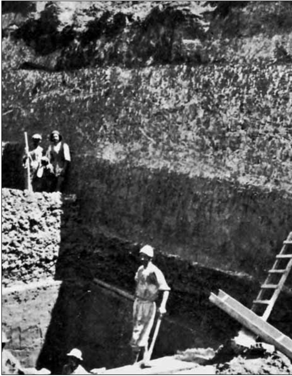
3. - Operai al lavoro nei primi decenni del XX secolo presso le cave di argilla ubicate in località Acqua dei Corsari (immagine tratta da Cipolla, 1931).
