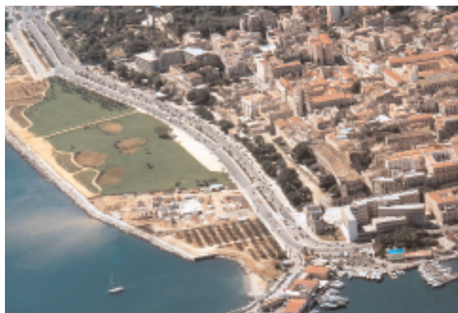
Palermo, il lungomare con la nuova villa sul riempimento, la stazione di sollevamento dei liquami urbani, il palmeto.
