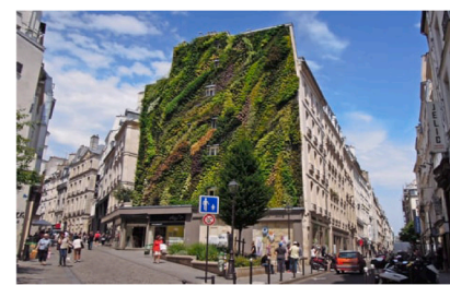
1c. Patrick Blanc's vertical garden on the corner of rue des Petits Carreaux
