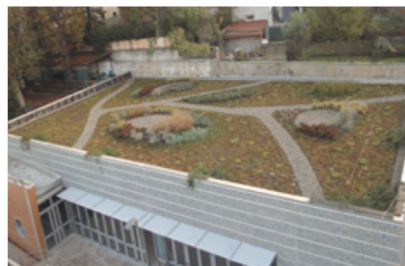
1b. Green roof bocciodromo "La Tesorina" in Corso Moncalieri in Turin
