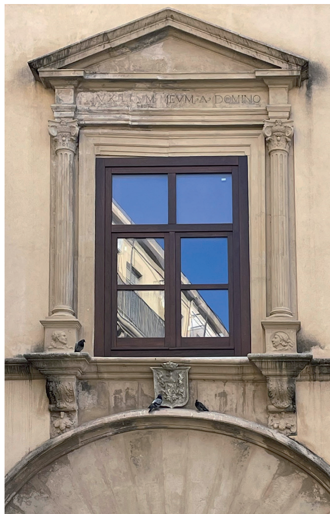
Fig. 1. Palermo. Palazzo Scavuzzo, finestra della facciata, 1547.
