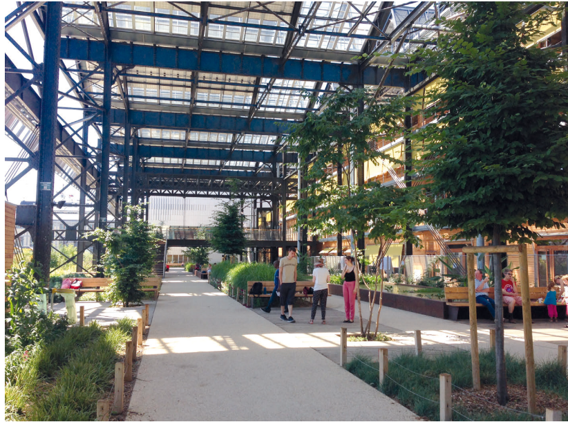
Figura 6 | Hall Pajol: giardino coperto dalla tettoia fotovoltaica realizzata sopra il tetto a shed dell'originaria struttura ferroviaria. A destra, i nuovi corpi di fabbrica realizzati in legno, ferro e cemento all'interno della struttura metallica recuperata. Fonte: ph Badami A.
