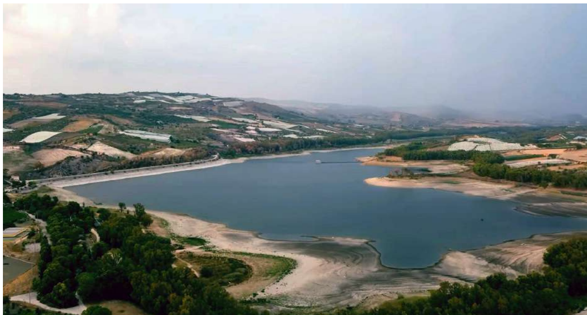
Figura 1 | Diga e relativo invaso San Giovanni, Comune di Naro (AG). Vista panoramica. Fonte: foto di A. Licata.
