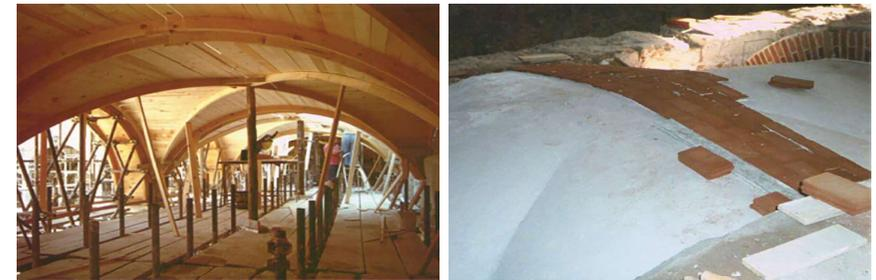
Fig. 6 - Intradosso delle casseforme utilizzate nel Convento di Sant'Anna La Misericordia, a sinistra, e posa del secondo strato di mattoni sopra lo strato di pasta di gesso fresca, a destra (© 2019, T. Campisi, M. Li Castri).
