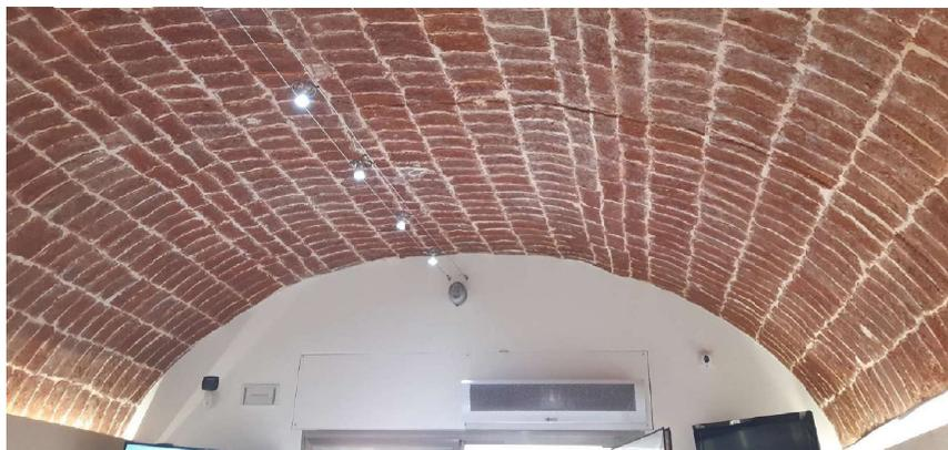
Fig. 1 - Volta realina sottoposta a scrostamento dell'intonaco dell'intradosso riscontrata nel centro storico di Partinico (© 2019, immagine degli autori).
