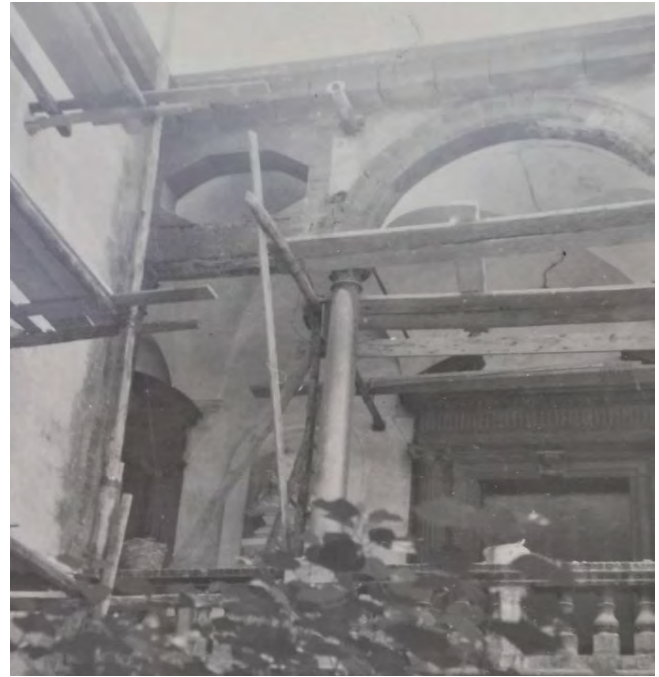
4: Oratorio di S. Cita, il chiostro con le impalcature realizzate dopo il bombardamento, 1944 (SBCAP AF).
