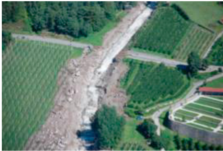
Fig. 1. Collapsed bridge after a debris flow event on the Rio di Tel (Parcines, BZ). Courtesy of Agenzia per la Protezione Civile della Provincia Autonoma di Bolzano.
