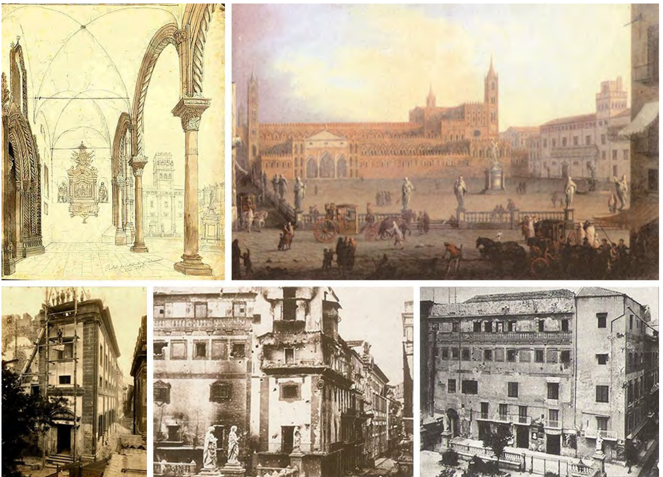
5: Fonti iconografiche e fotografiche per la ricostruzione dei fronti: disegno di A. Hallmann 1835, dipinto di P. Fabris 1770, foto eseguite durante i lavori di demolizione (post 1860)
