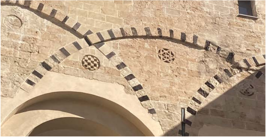
Fig. 1 - Palazzo Sclafani: particolare del cortile interno (foto di D. Santoro).
