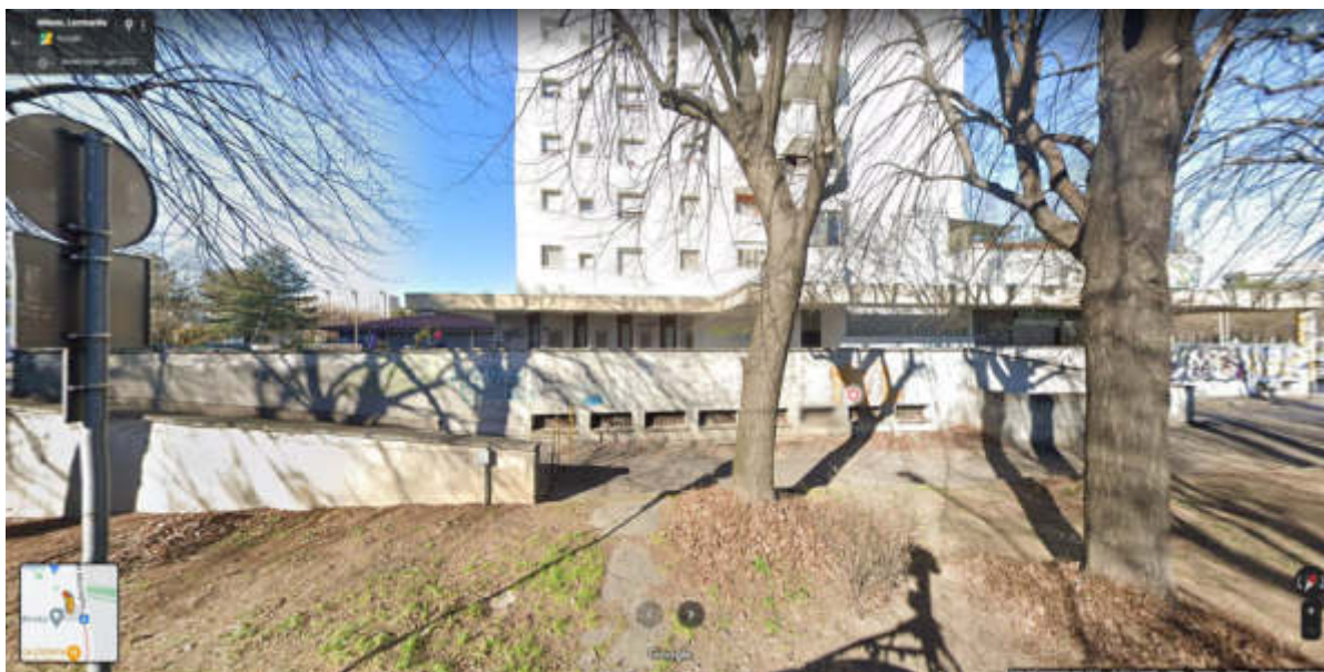
Fig. 2. Immagine catturata da Google Street View, che mostra l'inaccessibilità della "Piastra", ultimo luogo di incontro del percorso presso le Torri "bianche" di via Saponaro 36/38 dei BBPR 1963-71, veri e propri landmark nel quartiere.
