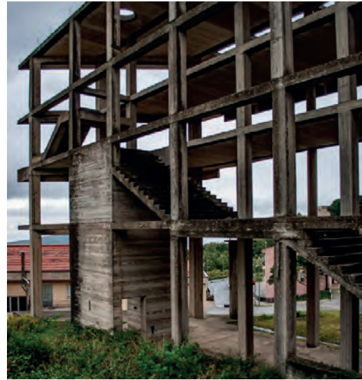
Fig. 6 | Costruzione incompiuta di partenza
