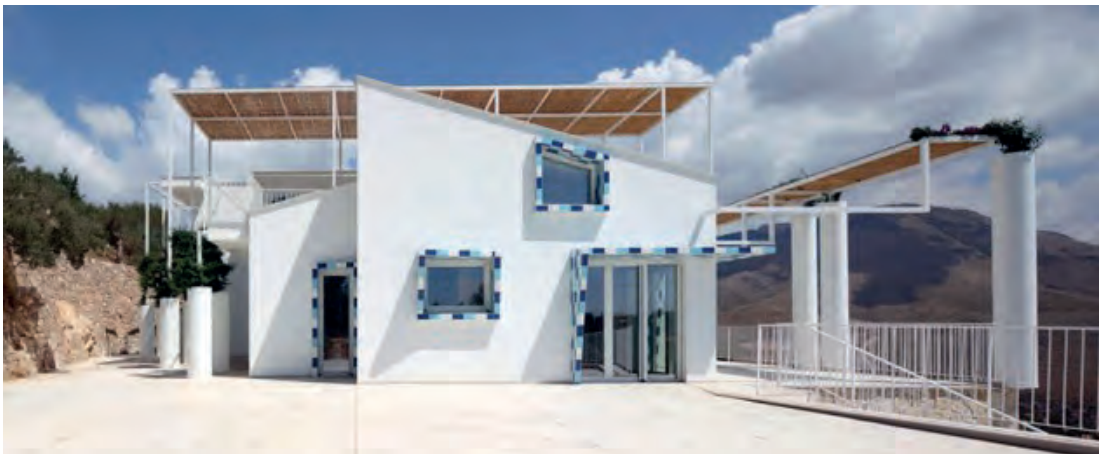
Fig. 6 | Intervento realizzato (vista dalla terrazza)
