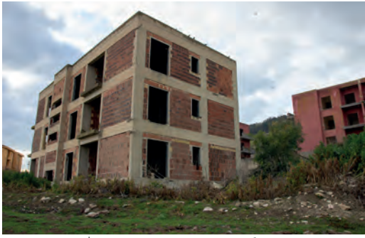
Fig. 3 | Costruzione incompiuta di partenza
