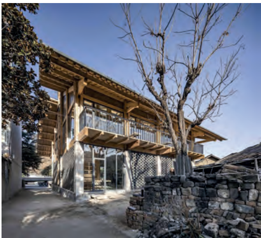
Fig. 8 | Intervento realizzato (prospetto principale)
