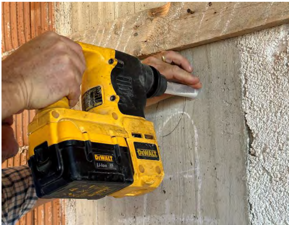
Fig. 116 | Predisposizione fori per il collocamento degli elettrodi (F. Anania, settembre 2022)
