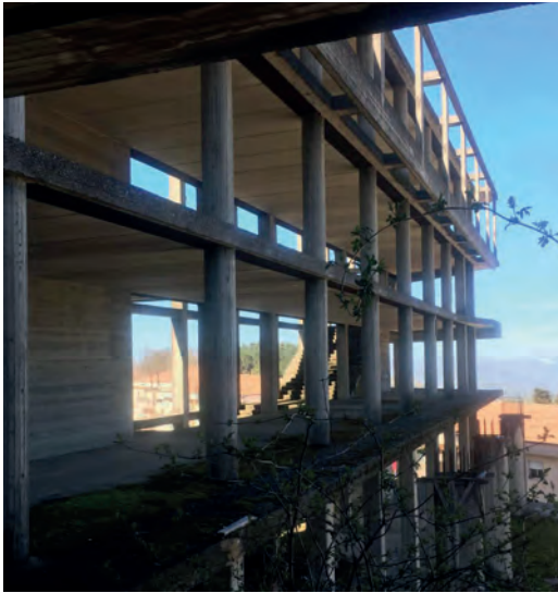
Fig. 5 | Costruzione incompiuta di partenza
