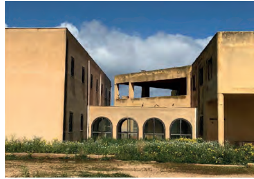
Fig. 5 | Costruzione incompiuta di partenza
