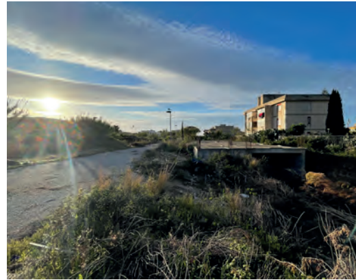
Fig. 5 | Costruzione incompiuta di partenza
