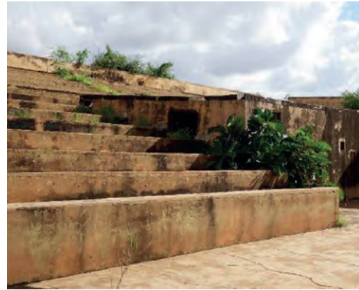
Fig. 5 | Costruzione incompiuta di partenza
