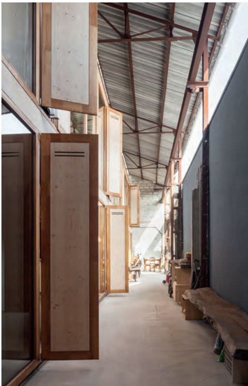
Fig. 11 | Intervento realizzato (dettaglio spazio filtro)
