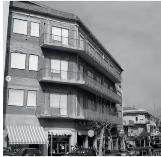
Fig. 10 | Costruzione incompiuta di partenza
