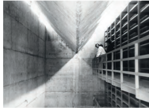
Fig. 6 | Struttura incompiuta di partenza (interno)
