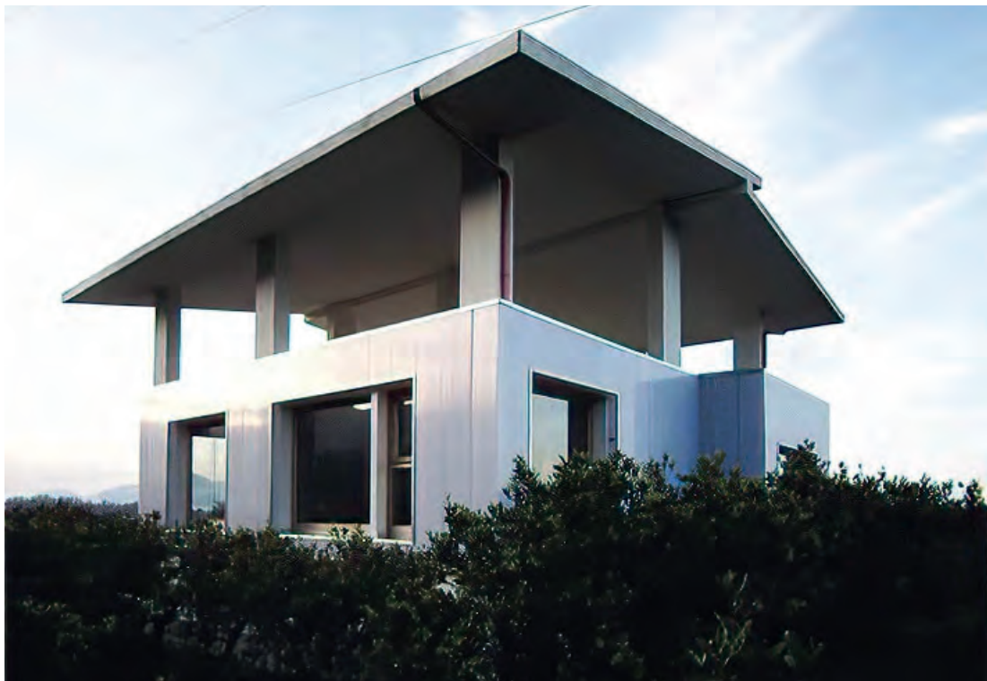
Fig. 8 | Intervento realizzato (vista dall'esterno delle chiusure verticali opache)
