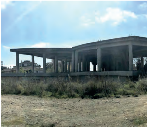
Fig. 4 | Costruzione incompiuta di partenza
