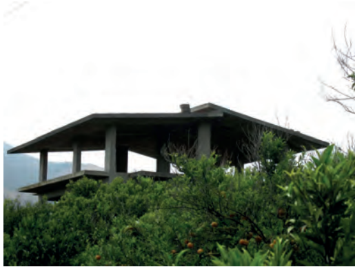
Fig. 6 | Costruzione incompiuta di partenza
