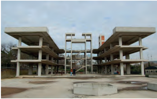
Fig. 6 | Costruzione incompiuta di partenza
