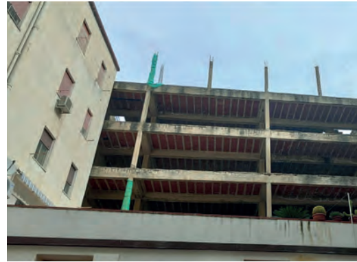
Fig. 6 | Costruzione incompiuta di partenza
