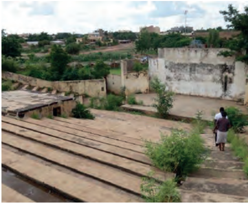
Fig. 4 | Costruzione incompiuta di partenza
