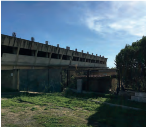
Fig. 5 | Costruzione incompiuta di partenza
