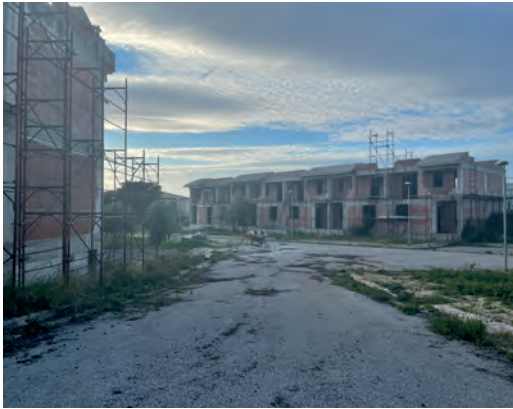
Fig. 4 | Costruzione incompiuta di partenza
