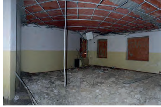
Fig. 4 | Costruzione incompiuta di partenza (dormitorio)
