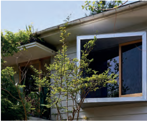
Fig. 2 | Intervento realizzato (dettaglio aperture)
