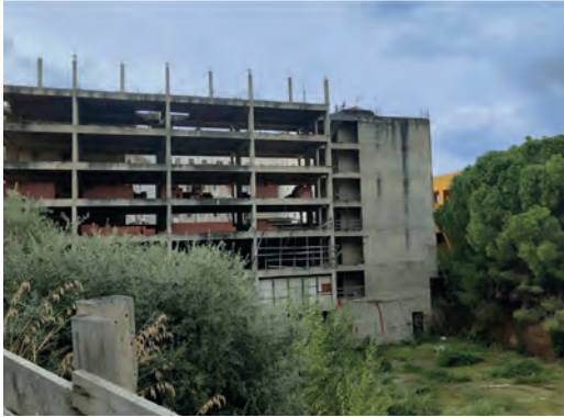
Fig. 4 | Costruzione incompiuta di partenza
