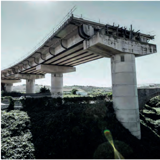
Fig. 4 | Costruzione incompiuta di partenza
