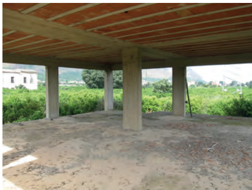
Fig. 7 | Costruzione incompiuta di partenza
