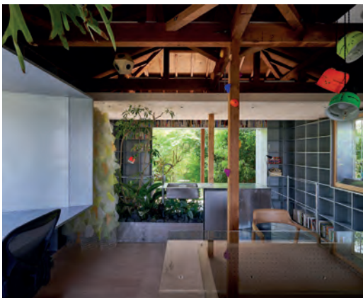
Fig. 6 | Intervento realizzato (struttura lignea)
