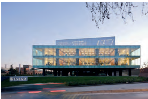
Fig. 8 | Intervento realizzato (prospetto principale)
