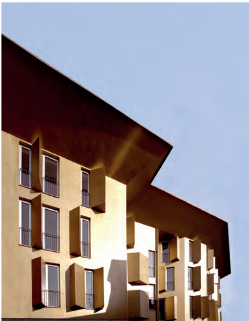
Fig. 9 | Intervento realizzato (prospetto secondario)
