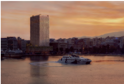
Fig. 8 | Intervento realizzato (vista da mare)
