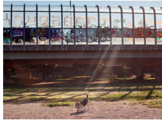
Fig. 8 | Costruzione incompiuta di partenza
