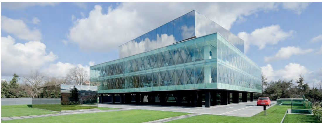
Fig. 12 | Intervento realizzato (vista da strada)
