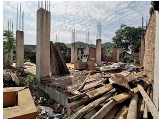
Fig. 7 | Costruzione incompiuta di partenza
