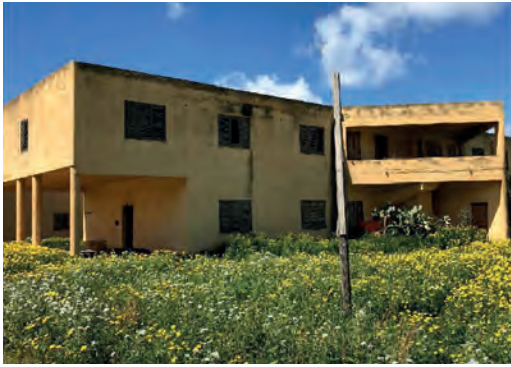
Fig. 4 | Costruzione incompiuta di partenza
