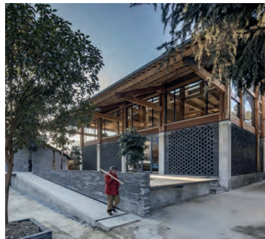
Fig. 9 | Intervento realizzato (prospetto principale)
