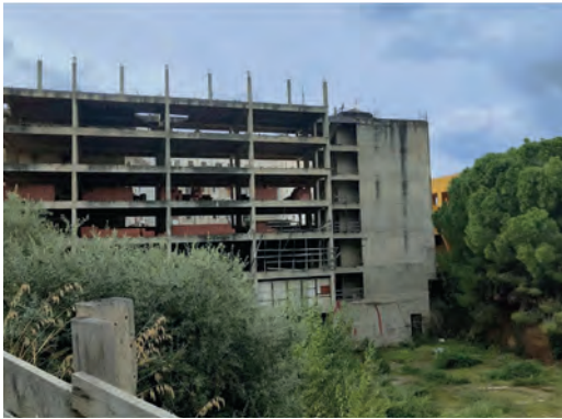
Fig. 5 | Costruzione incompiuta di partenza
