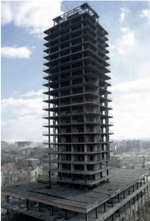
Fig. 6 | Costruzione incompiuta di partenza
