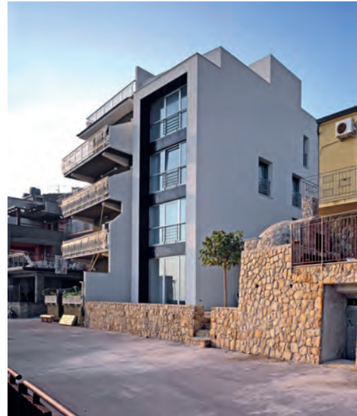
Fig. 10 | Intervento realizzato (dettaglio ingresso al livello 0)
