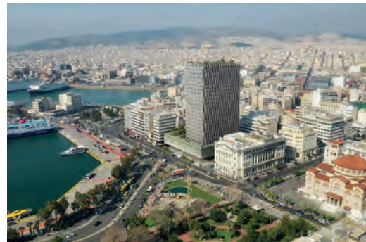
Fig. 9 | Intervento realizzato con inquadramento
