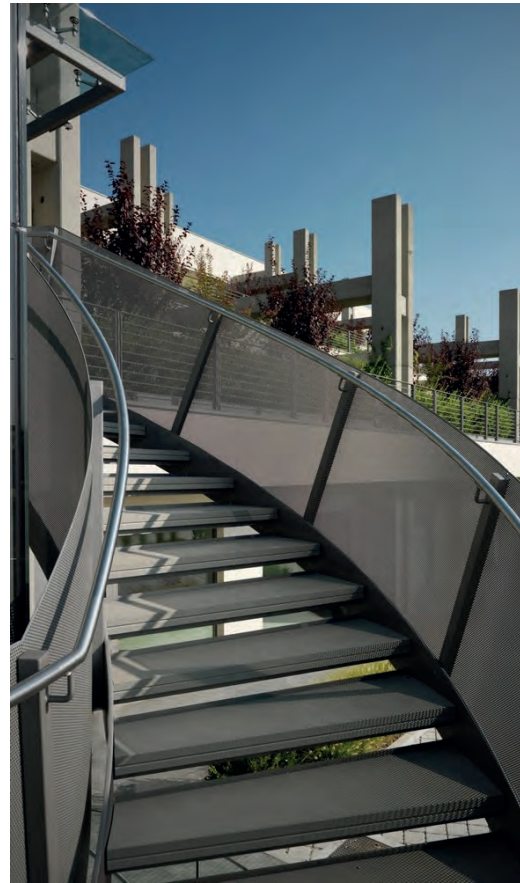
Fig. 8 | Intervento realizzato (sistemi di risalita)
