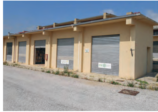
Fig. 4 | Costruzione incompiuta di partenza
