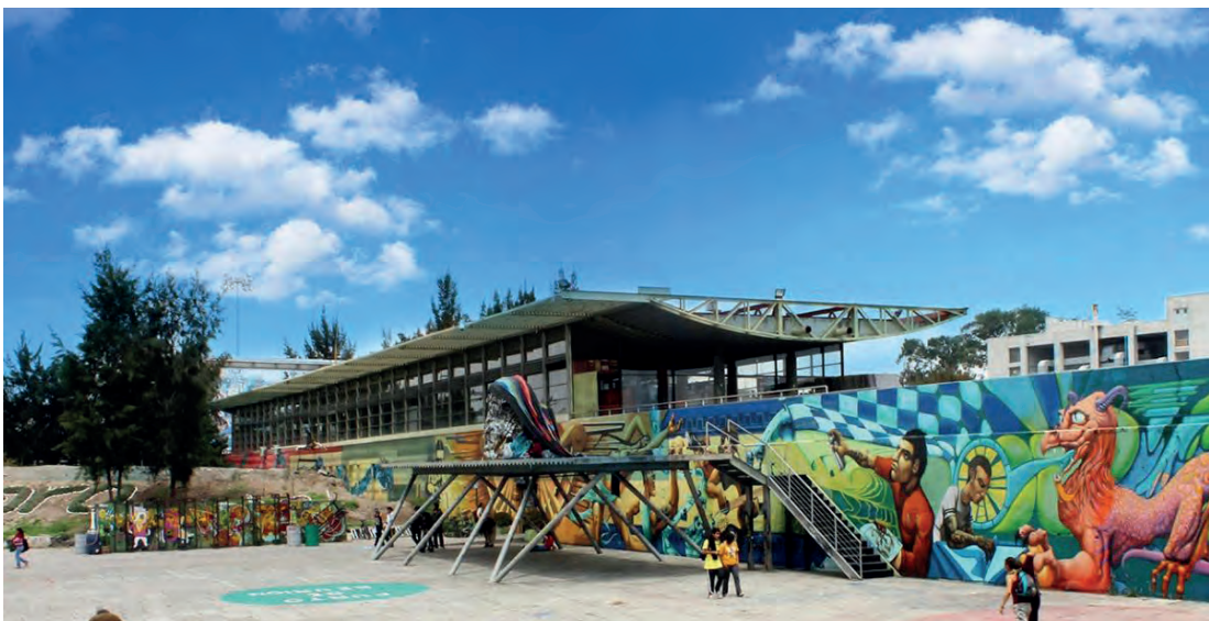
Fig. 9 | Intervento realizzato (pertinenza esterna e facciata principale edificio)
