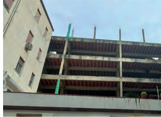
Fig. 5 | Costruzione incompiuta di partenza
