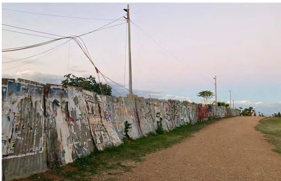
Figura I | La recinzione del ventennale cantiere del collettore fognario del Foro Italico a Palermo, teatro di continui vandalismi e dello stupro di gruppo dell'estate del 2023, fatto emblematico della “mala-movida” cittadina (M.L. Germanà, novembre 2023)
