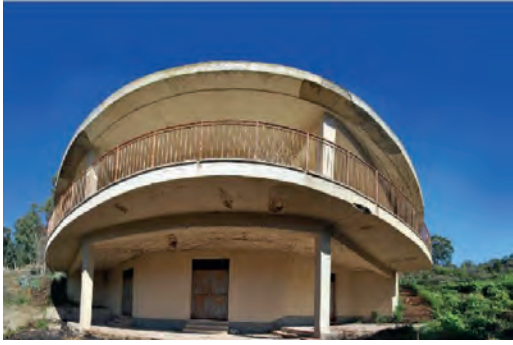
Fig. 3 | Costruzione incompiuta di partenza
