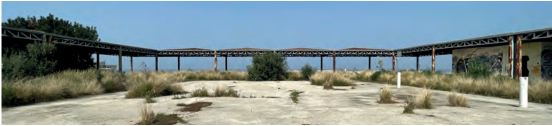
Fig. 4 | Costruzione incompiuta di partenza
