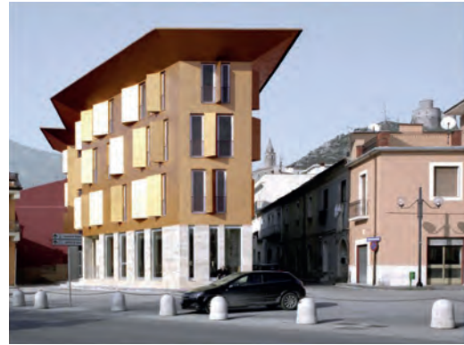
Fig. 11 | Intervento realizzato (prospetto principale)
