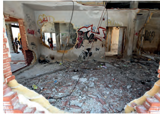
Fig. 7 | Costruzione incompiuta di partenza
