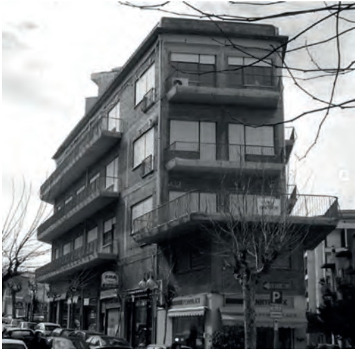
Fig. 9 | Costruzione incompiuta di partenza
