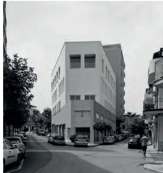
Fig. 12 | Intervento realizzato (prospetto principale)
