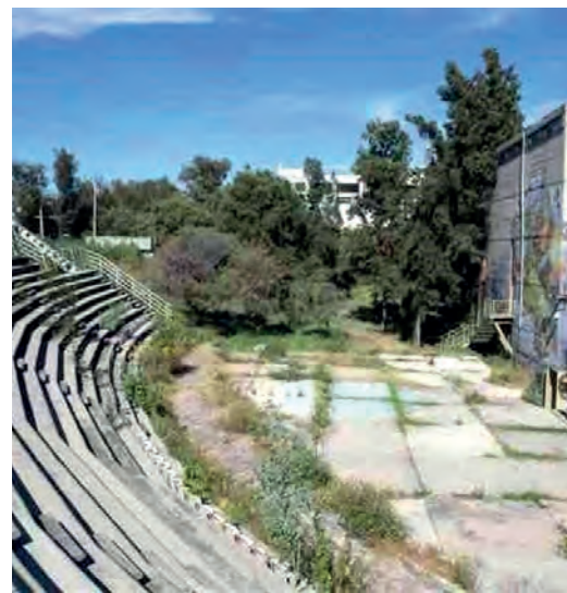
Fig. 8 | Intervento realizzato (particolare anfiteatro esterno)
