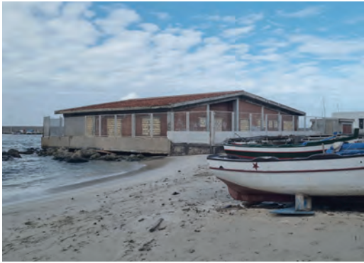
Fig. 6 | Costruzione incompiuta di partenza
