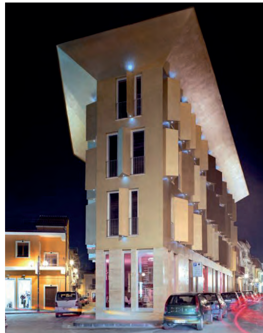
Fig. 12 | Intervento realizzato (prospetto principale)
