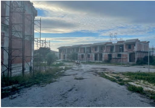
Fig. 5 | Costruzione incompiuta di partenza
