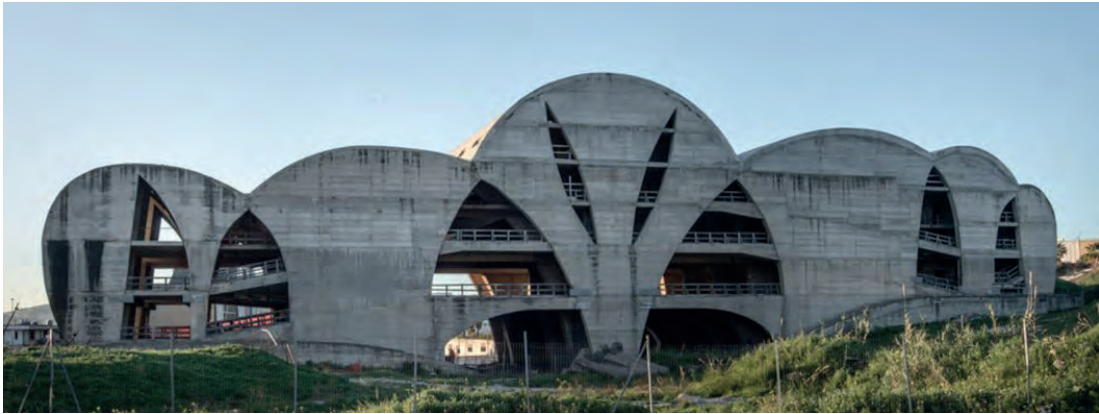
Fig. 4 | Costruzione incompiuta di partenza
