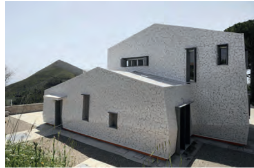
Fig. 7 | Intervento realizzato (vista dall'esterno)
