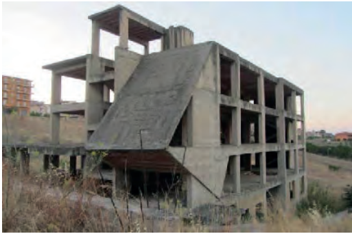
Fig. 3 | Costruzione incompiuta di partenza
