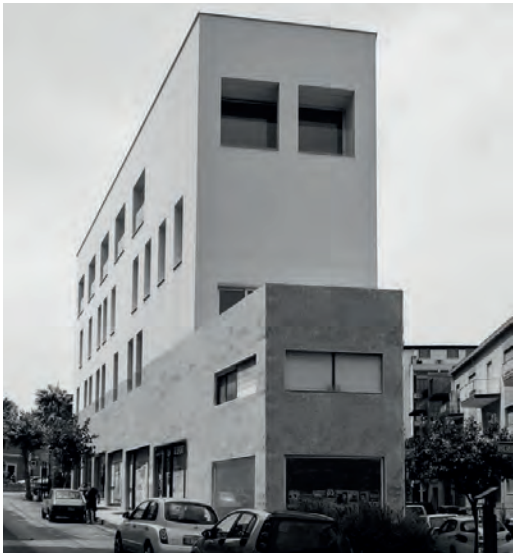
Fig. 11 | Intervento realizzato (prospetto principale)
