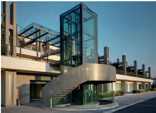
Fig. 7 | Intervento realizzato (sistemi di risalita)
