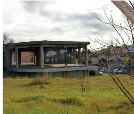
Fig. 5 | Costruzione incompiuta di partenza
