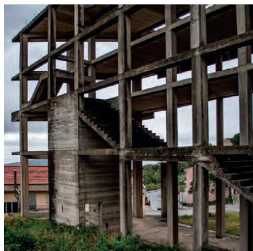
Fig. 6 | Costruzione incompiuta di partenza
