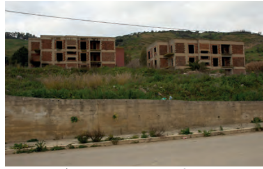
Fig. 4 | Costruzione incompiuta di partenza
