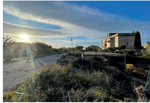
Fig. 6 | Costruzione incompiuta di partenza
