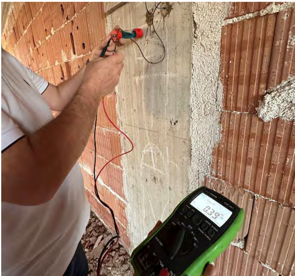
Fig. 128 | Rilevazione stato tensionale con tester (F. Anania, settembre 2023)
