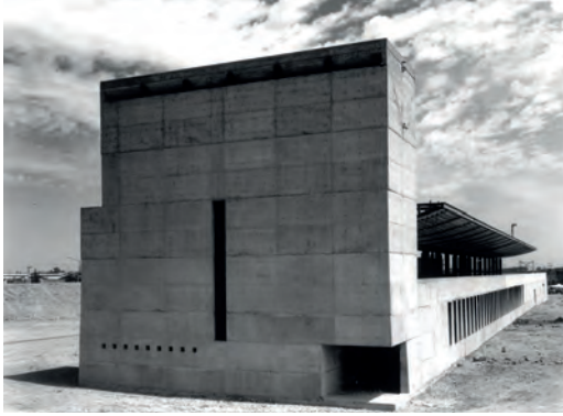
Fig. 5 | Struttura incompiuta di partenza (esterno)
