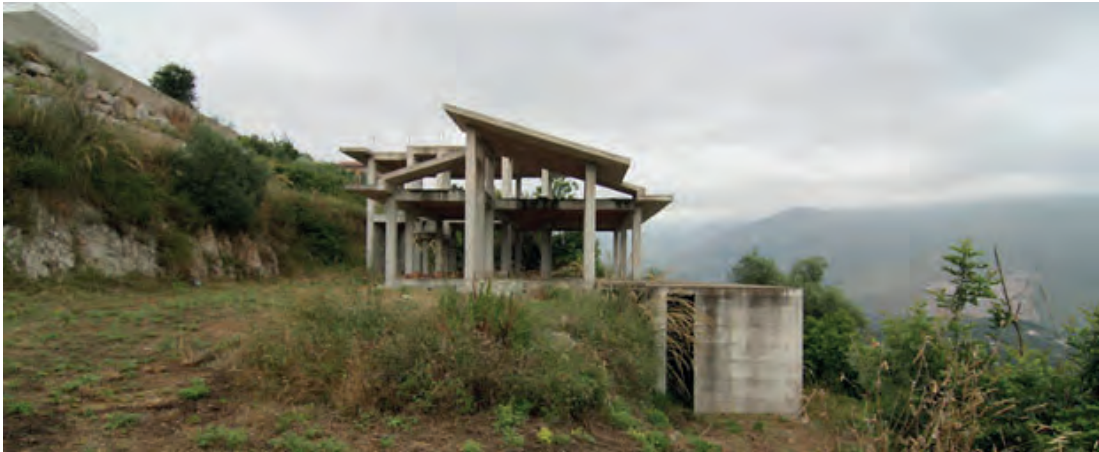
Fig. 5 | Costruzione incompiuta di partenza
