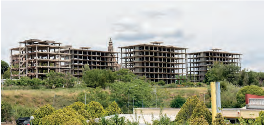
Fig. 7 | Costruzione incompiuta di partenza
