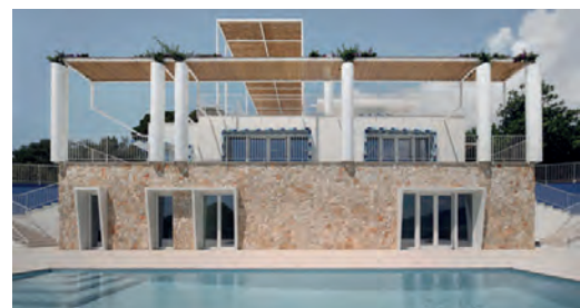
Fig. 9 | Intervento realizzato (prospetto su piscina)
