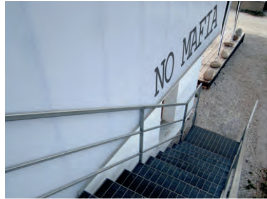
Fig. 9 | Intervento realizzato (particolare sistema di risalita)
