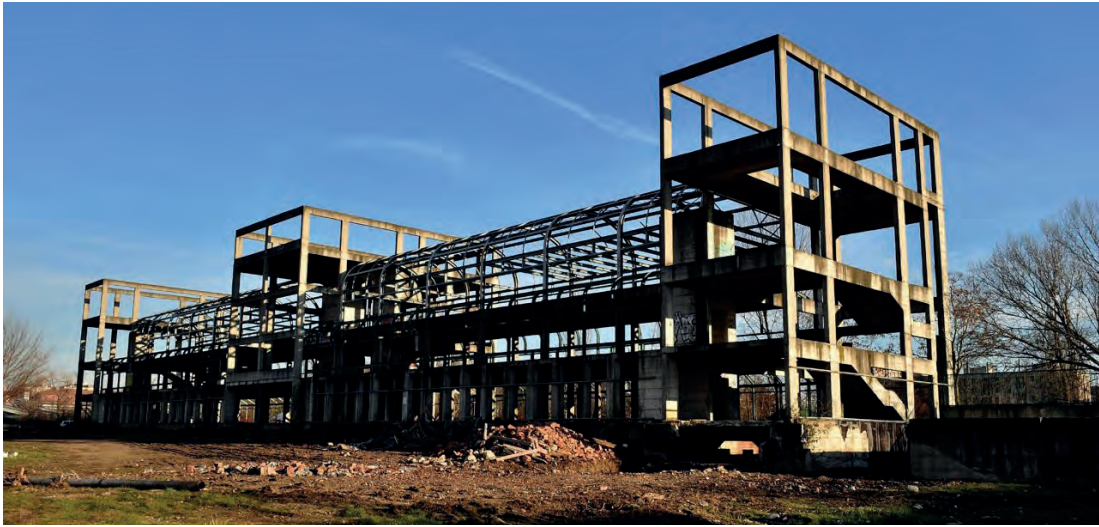
Fig. 6 | Costruzione incompiuta di partenza
