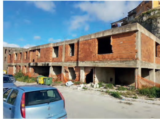
Fig. 7 | Costruzione incompiuta di partenza
