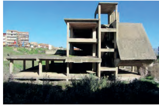
Fig. 4 | Costruzione incompiuta di partenza
