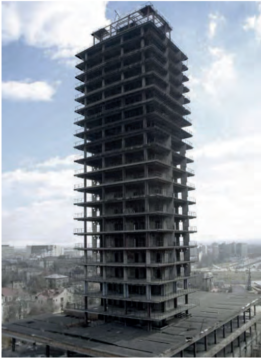
Fig. 6 | Costruzione incompiuta di partenza
