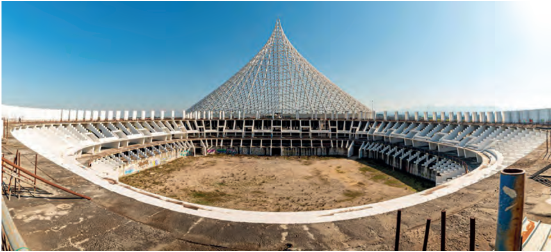
Fig. 4 | Costruzione incompiuta di partenza
