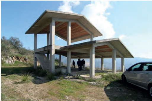
Fig. 6 | Costruzione incompiuta di partenza
