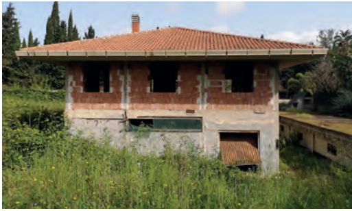
Fig. 5 | Costruzione incompiuta di partenza
