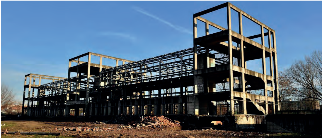
Fig. 3 | Costruzione incompiuta di partenza
