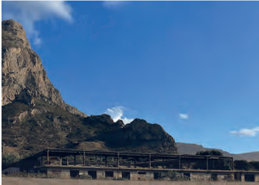
Fig. 5 | Costruzione incompiuta di partenza
