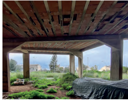
Fig. 6 | Costruzione incompiuta di partenza
