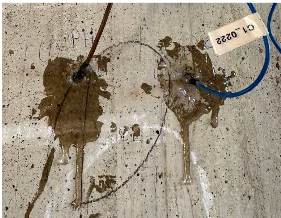
Fig. 122 | Elettrodi ad installazione avvenuta (F. Anania, settembre 2023)
