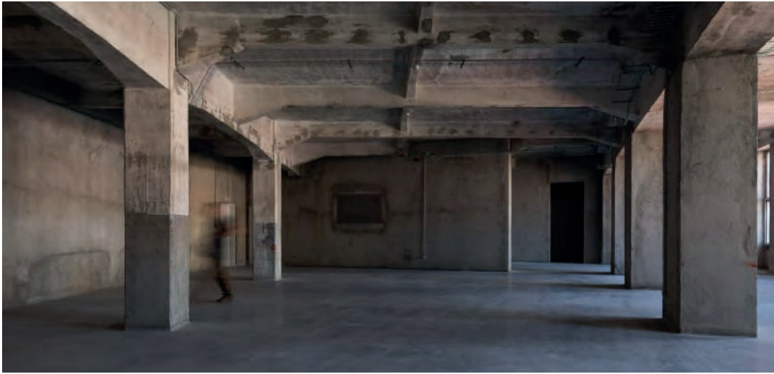
Fig. 4 | Costruzione incompiuta di partenza
