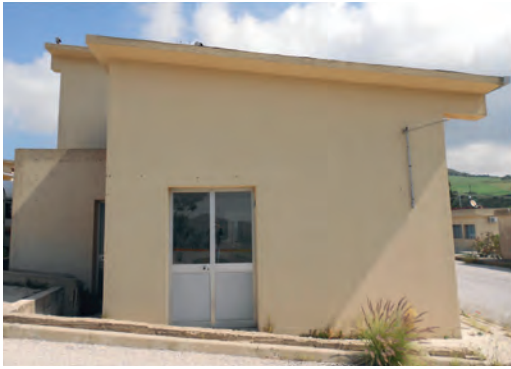
Fig. 3 | Costruzione incompiuta di partenza
