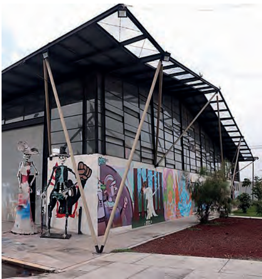
Fig. 7 | Intervento realizzato (particolare murales esterni)
