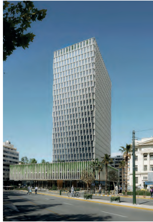
Fig. 7 | Intervento realizzato (prospetto principale)
