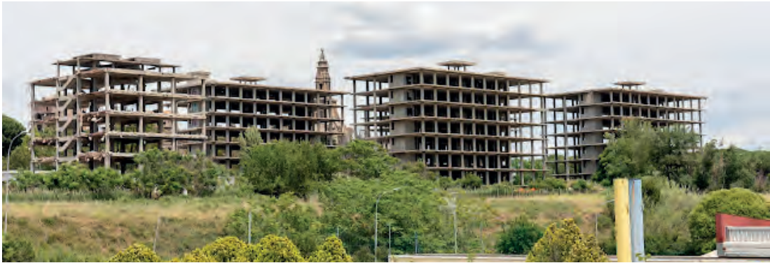
Fig. 5 | Costruzione incompiuta di partenza
