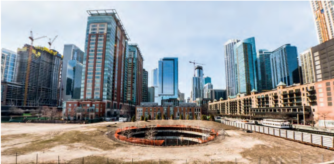
Fig. 2 | Costruzione incompiuta di partenza
