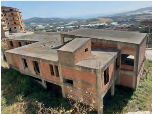
Fig. 6 | Costruzione incompiuta di partenza
