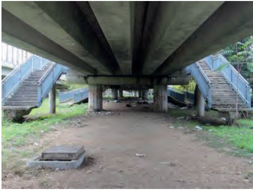
Fig. 4 | Costruzione incompiuta di partenza
