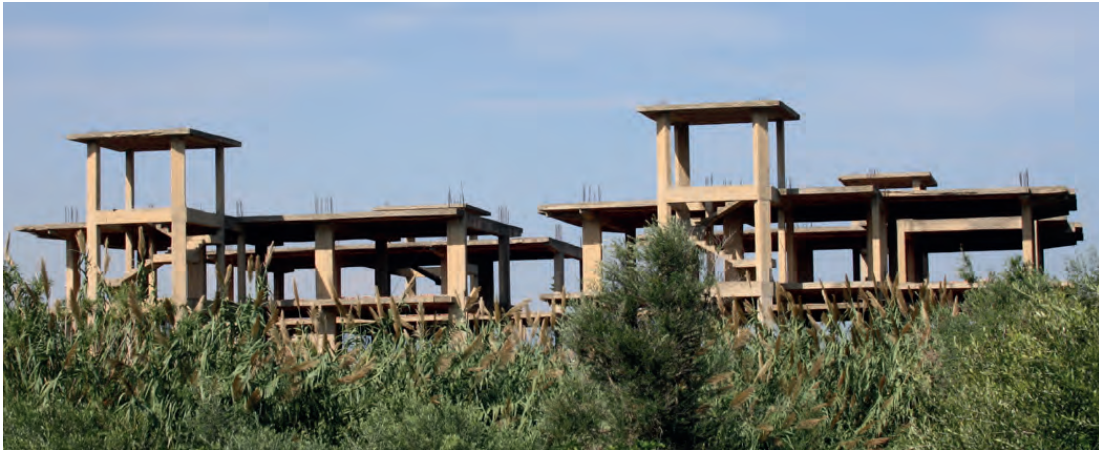
Fig. 7 | Costruzione incompiuta di partenza
