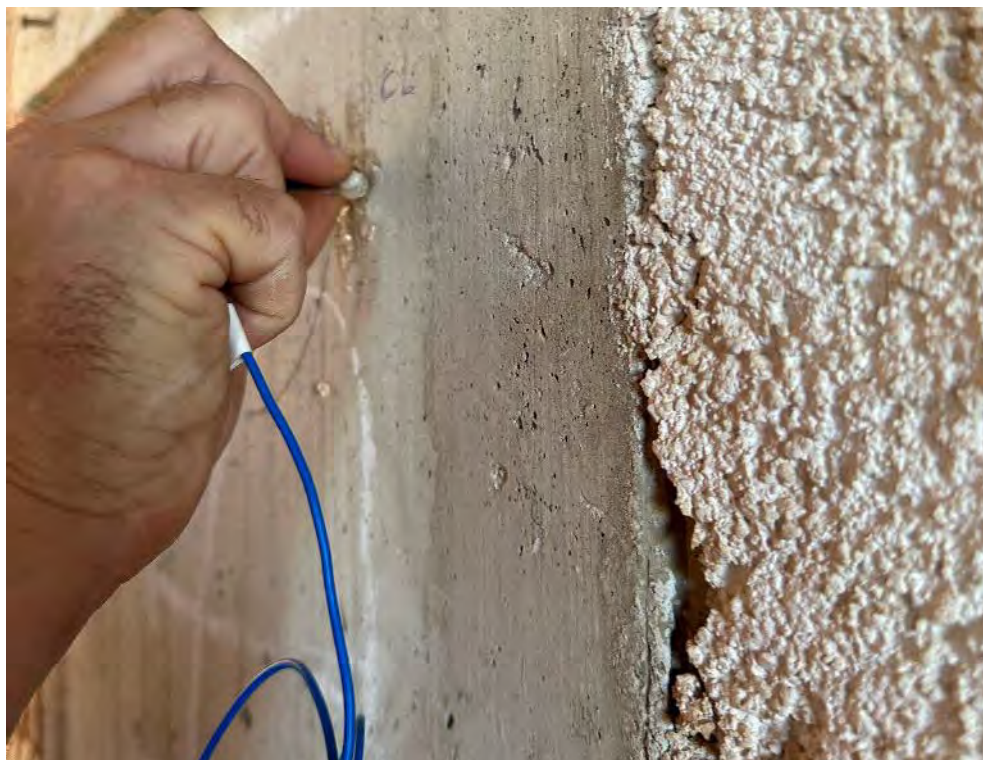
Fig. 120 | Collocamento elettrodi nei fori predisposti (F. Anania, settembre 2023)
