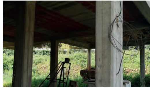
Fig. 6 | Costruzione incompiuta di partenza
