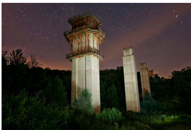
Fig. 24 | Viadotto di Valle San Lorenzo ad Agnone (credit: Angelo Antolino)
