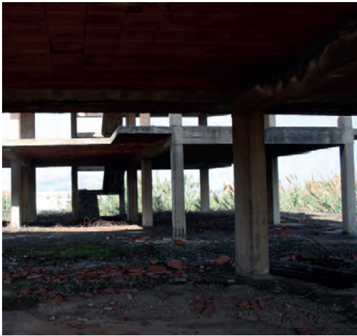
Fig. 8 | Costruzione incompiuta di partenza
