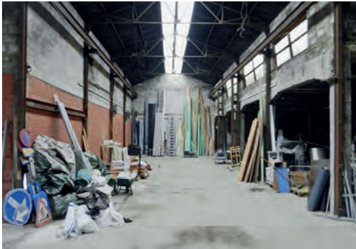
Fig. 9 | Costruzione incompiuta di partenza
