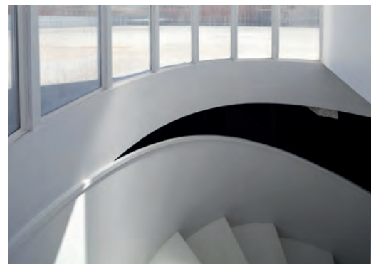
Fig. 8 | Intervento realizzato (nuovo collegamento verticale)
