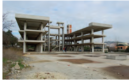
Fig. 7 | Costruzione incompiuta di partenza
