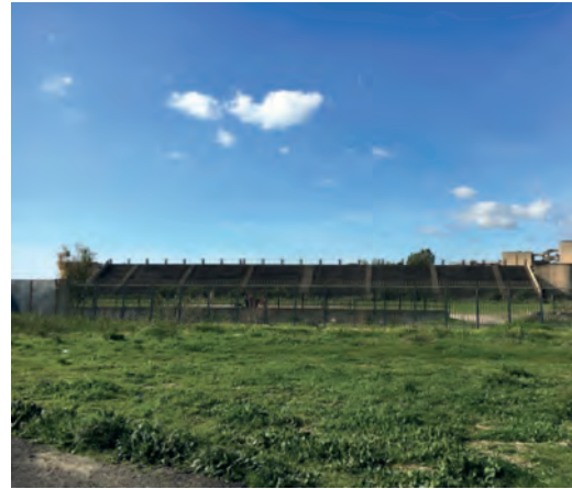
Fig. 6 | Costruzione incompiuta di partenza
