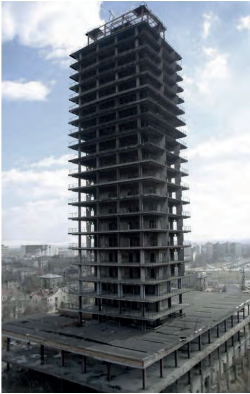
Fig. 6 | Costruzione incompiuta di partenza
