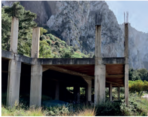
Fig. 5 | Costruzione incompiuta di partenza
