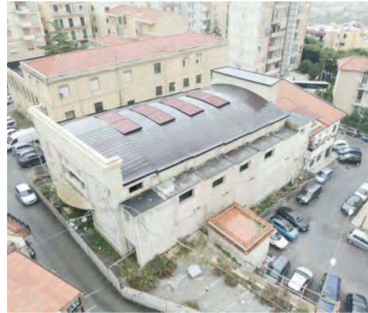
Fig. 6 | Costruzione incompiuta di partenza
