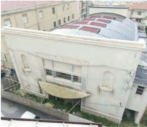
Fig. 5 | Costruzione incompiuta di partenza
