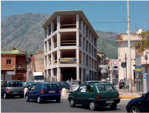
Fig. 8 | Struttura incompiuta di partenza (esterno)
