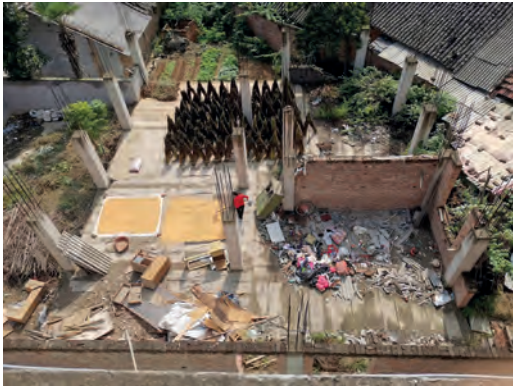
Fig. 6 | Costruzione incompiuta di partenza
