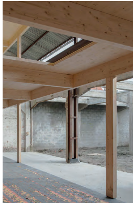
Fig. 13 | Intervento realizzato (dettaglio struttura lignea)
