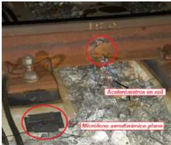
Figura 4. Instrumentación vibro-acústica en campo cercano utilizando un micrófono comercial plano instalado en la traviesa de una línea de alta velocidad, combinado con acelerómetros instalados en el raíl [2].
