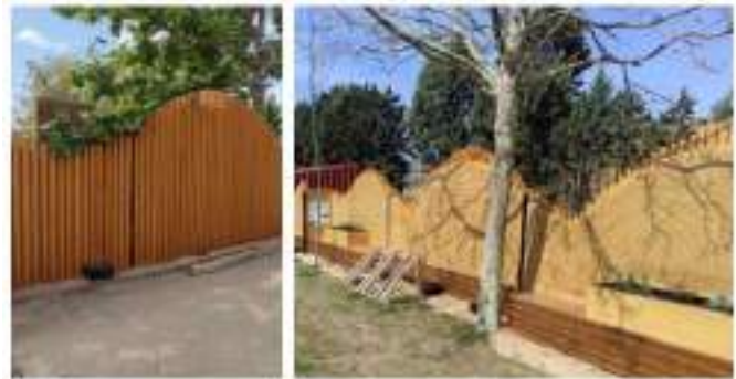
Figura 12. Barrera multifuncional instalada.
