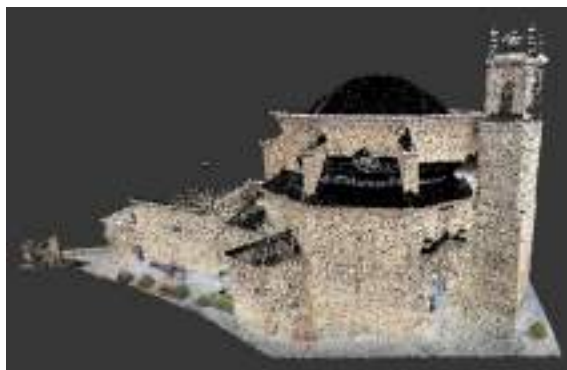
Figura 1. Exterior de la iglesia de San Pedro obtenido a partir de medición de nube de puntos (LiDAR ZEB Horizon®).
