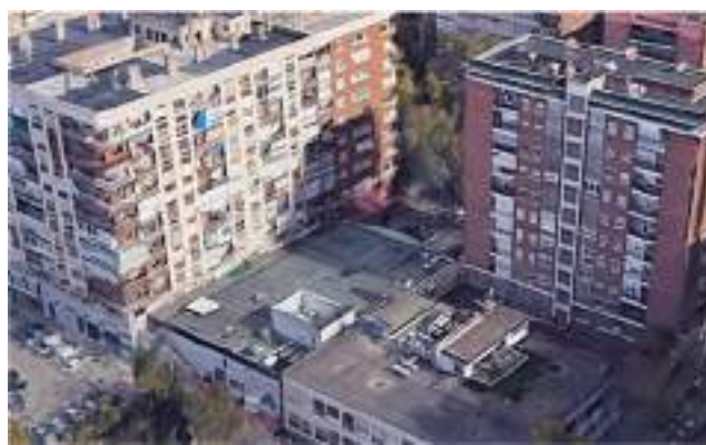
Figura 1. Vista de equipos en cubierta apantallados en presencia de edificaciones residenciales de mayor altura. (Fte: Google Earth)
