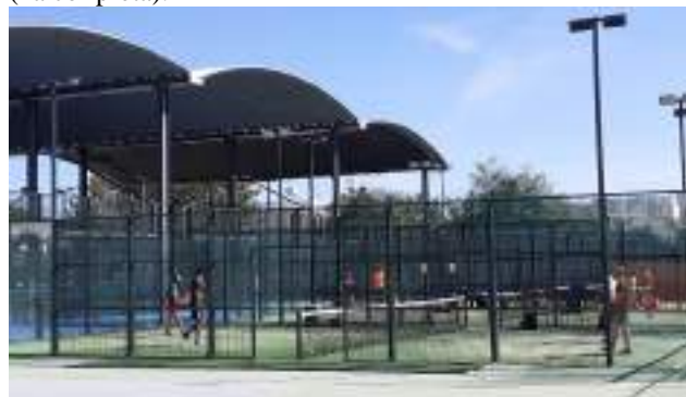
Figura 1. Imagem geral de 3 campos de padel cobertos (cobertura metálica autoportante) ao lado de outros 3 campos de padel descobertos (do lado direito).
