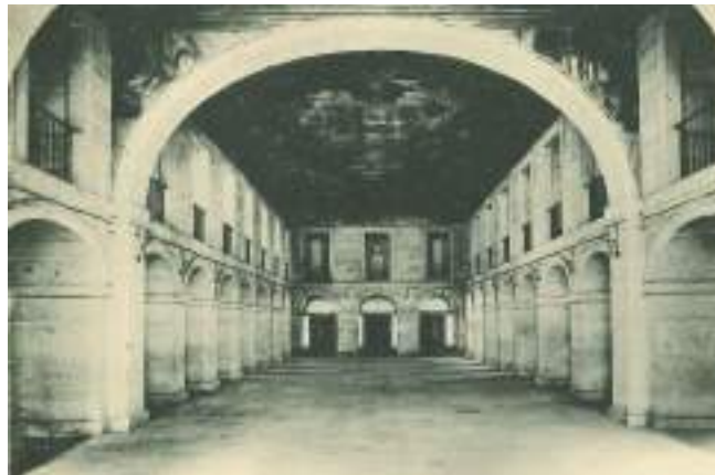
Figura 1. Lonja del Colegio antes de la construcción del salón de actos.
