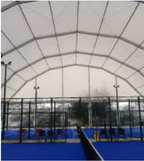
Figura 2. Imagem geral do interior de “tenda”, envolvida por telas flexíveis, com 3 campos de padel no seu interior.
