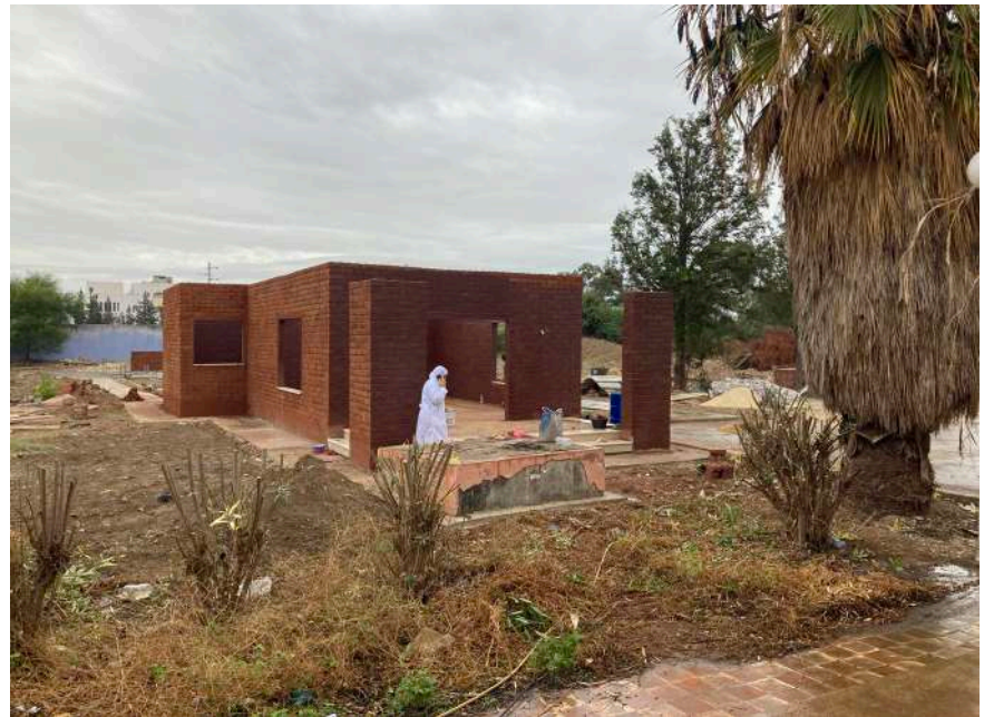
Fig. 2 - Sede della CITET ( Centre International des Technologies de l'Environnement de Tunis ) a Tunisi. Edificio dimostrativo CUBÂTI realizzato con blocchi di terra cruda compressa, durante la fase di costruzione / Headquarters of CITET (Centre International des Technologies de l'Environnement de Tunis) in Tunis. CUBÂTI demonstration building made of compressed earthen blocks, during the construction phase (Source: M. L. Germanà).
