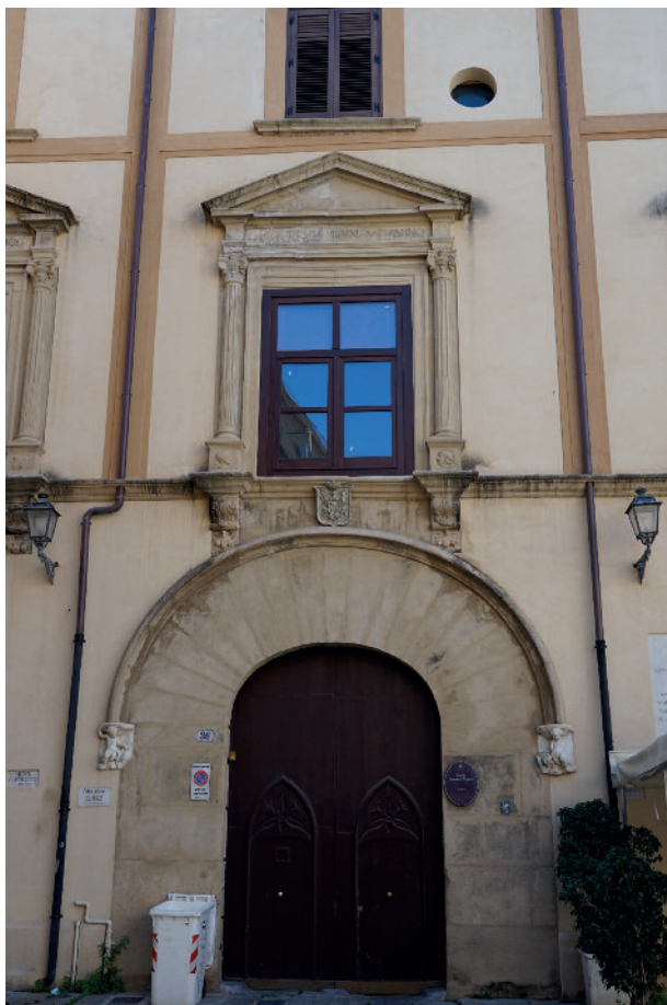
fig. 6 Palermo, palazzo Scavuzzo, particolare del partito centrale della facciata principale (con portale e finestra sovrastante), 1547 (fotografia Emanuela Garofalo).
