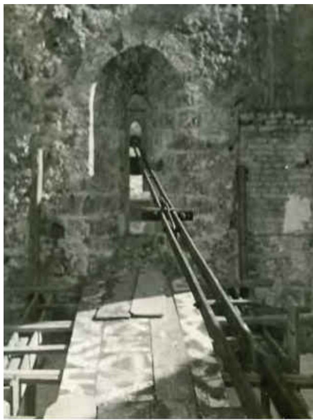
2: Agrigento, ex monastero di Santo Spirito. Ancoraggio delle catene provvisorie. Fondo Guiotto.
