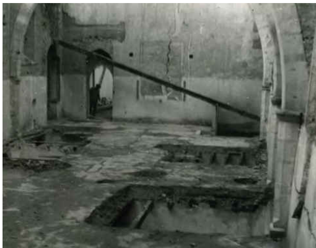
3: Agrigento, ex monastero di Santo Spirito. Rovine dell'ex - dormitorio, in evidenza il muro est (a destra) ruotato e lesionato al piede - luglio 1943. Fondo Guiotto.
