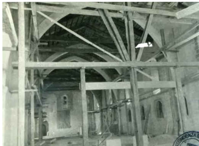
4: Agrigento, ex monastero di Santo Spirito. Veduta dell'aula del dormitorio durante i lavori di realizzazione della nuova copertura. Neg. n. 2223.
