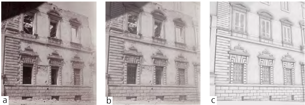
Fig. 28/ Verifica della corrispondenza proiettiva fra la prima fotografia e il modello. a) Opacità piena della fotografia. b) Opacità 50%. c) Piena trasparenza della fotografia.
