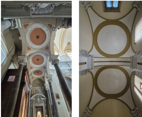
FIG. 2-3 Palermo, Chiesa di Santa Teresa alla Kalsa, veduta del vestibolo-sottocoro (foto di M. R. Nobile)
