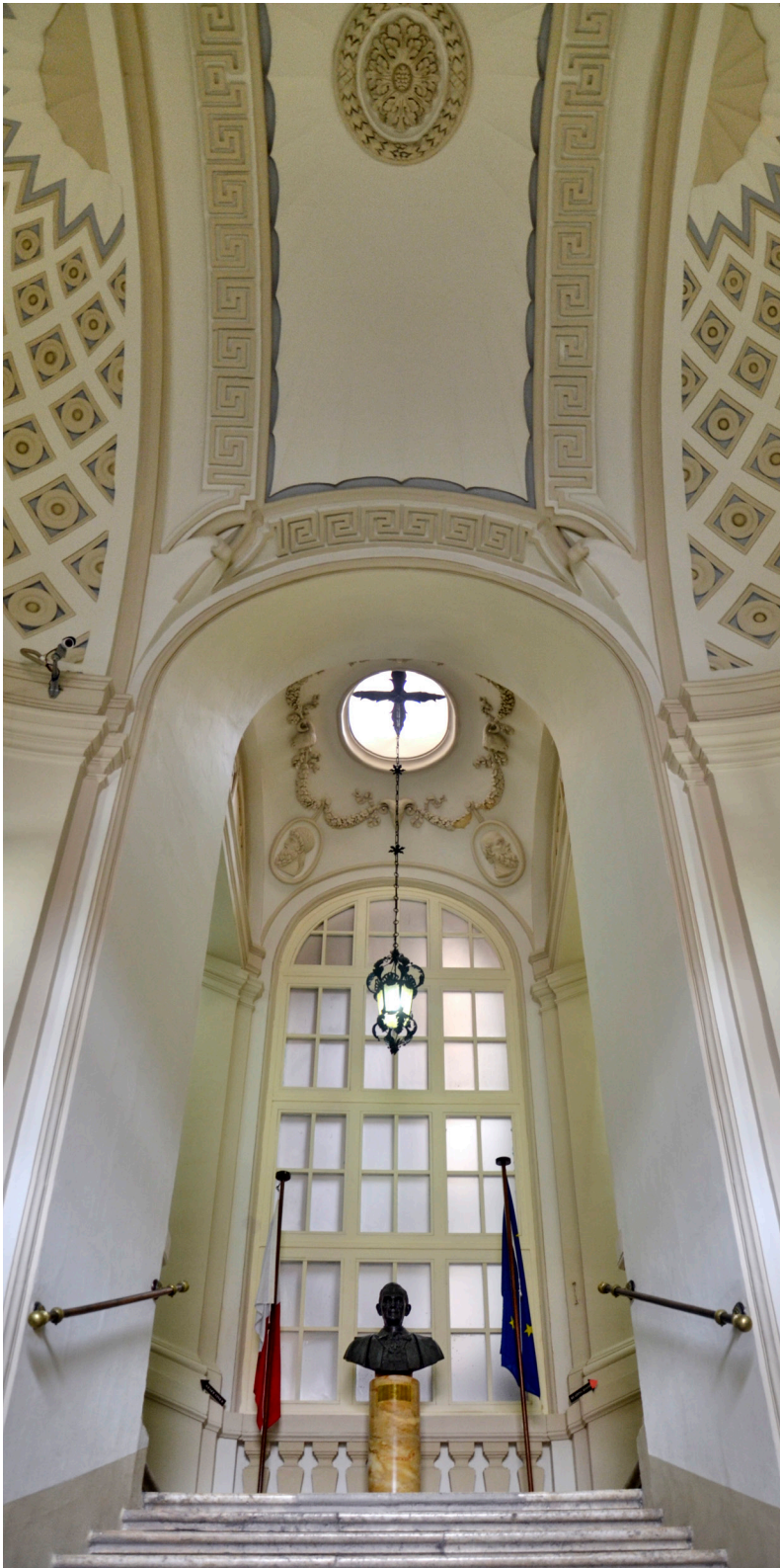
Fig. 9. Veduta della prima rampa della scala della Biblioteca della Valletta, sormontata da una volta a botte inclinata [fotografia dell'autore, 2017].
