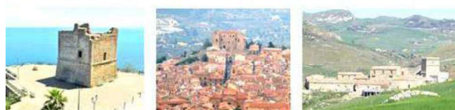
Fig.6 Sistema insediativo fortificato delle Madonie. Procedendo da sx verso dx sono riportate le foto della Torre costiera di Pollina, del castello ventimigliano di Castelbuono e della masseria fortificata "Capuano" nel territorio di Gangi
