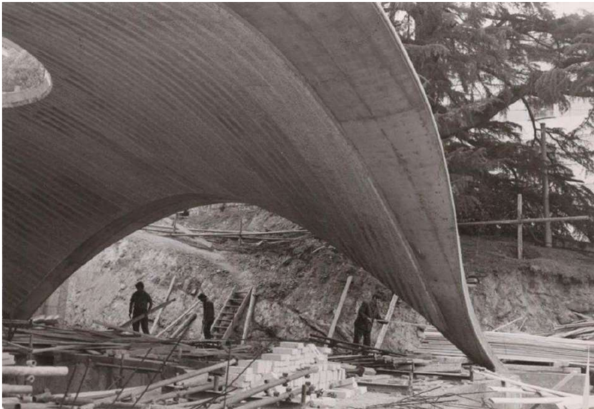
Figura IV.60. Intradosso del guscio durante la fase di realizzazione (gta Archiv/archivio Isler 217_0292_FX_1_1).
