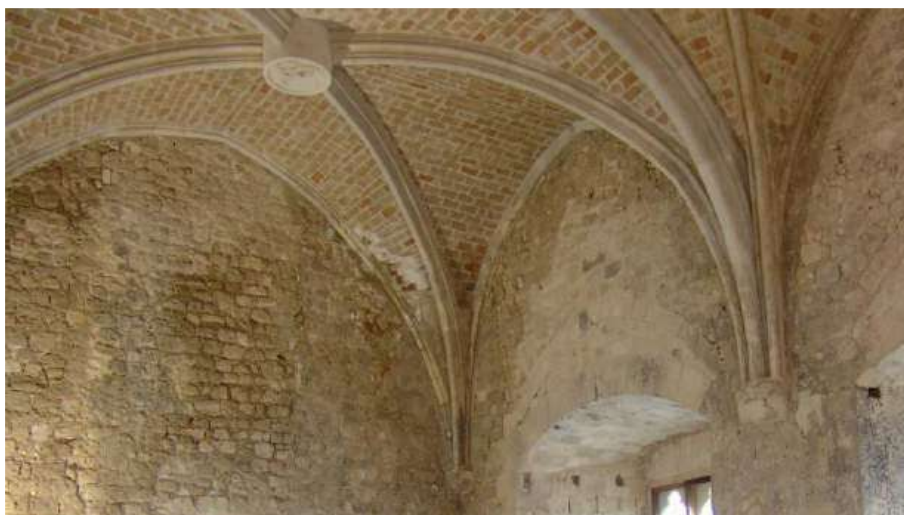
Figura II.4. Una delle volte sottili della torre-palazzo di Pozzallo (Nobile, 2020).
