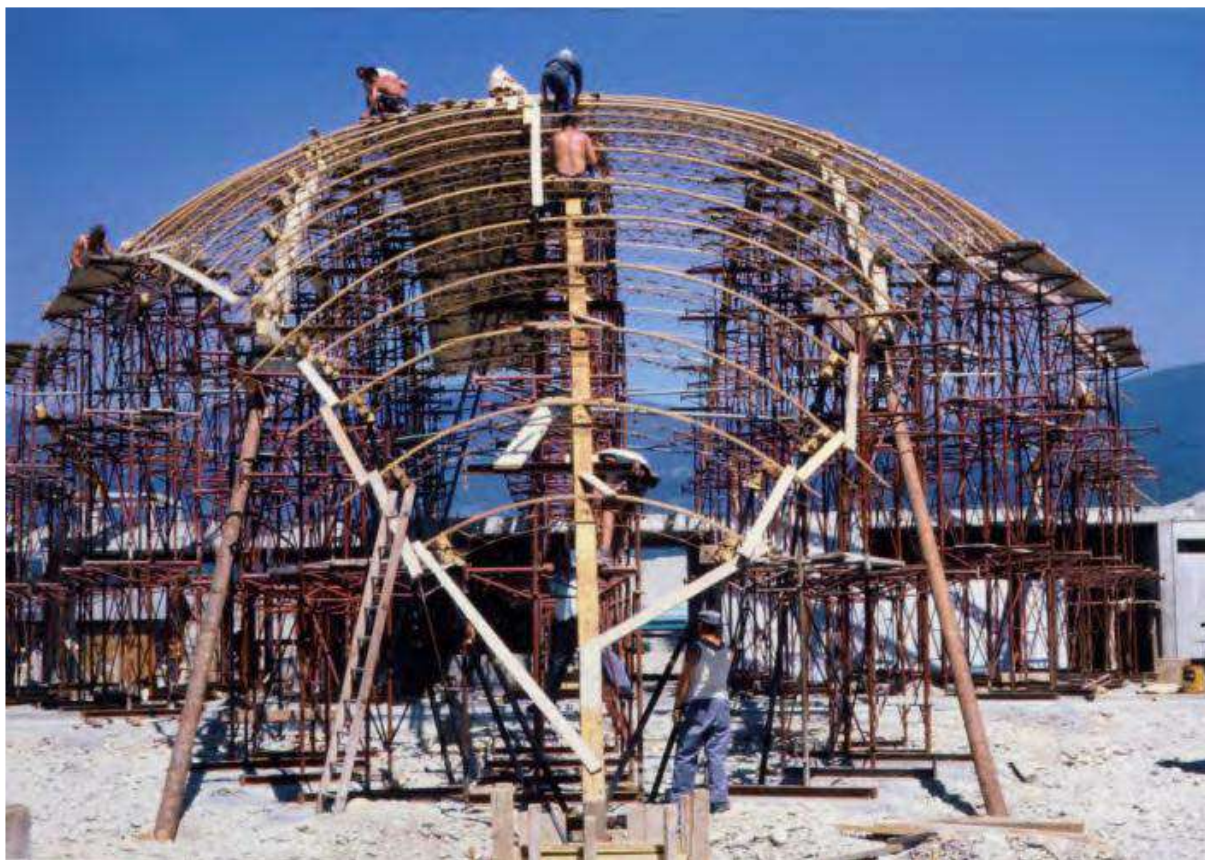
Figura IV.38. Fase di centinatura del guscio (Bösiger, 2011).
