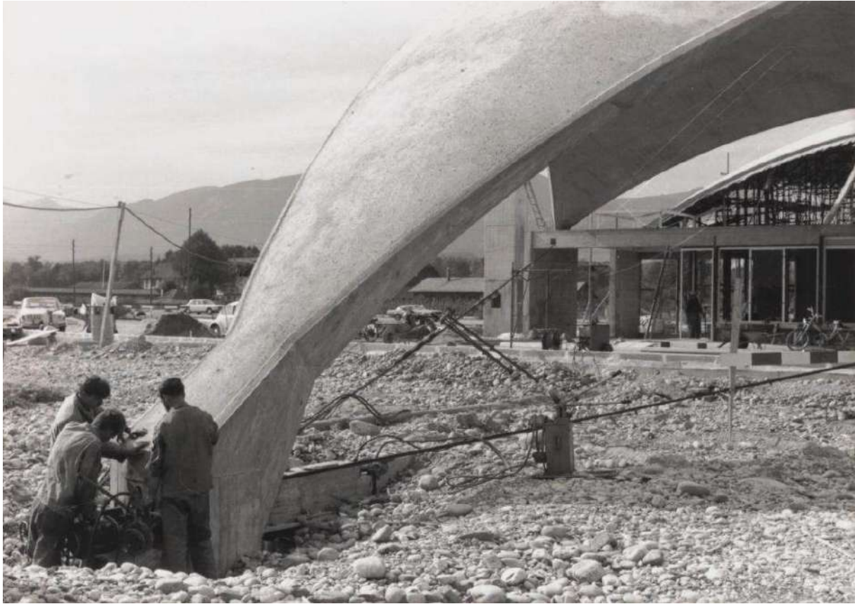
Figura IV.41. Dettaglio dell'appoggio inferiore (gta Archiv/archivio Isler rif. 217_0140_F_3).
