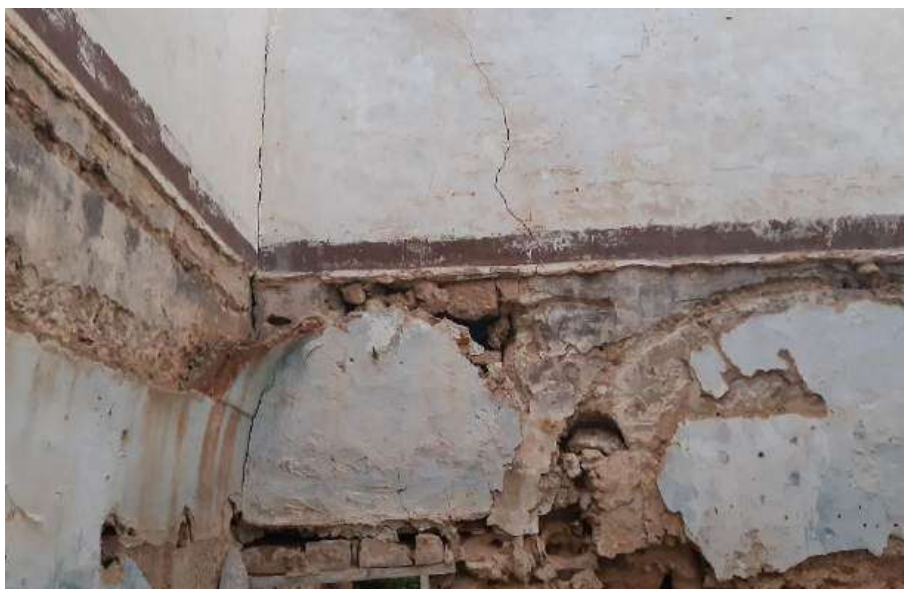
Figura III.7. Volte realine a botte collassate in cui è visibile l' insaraciato per l'alloggiamento dei mattoni delle volte e delle relative controvoltine. Tracce di picchettamento sono visibili anche parallelamente alla direttrice delle volte (foto dell'Autore).
