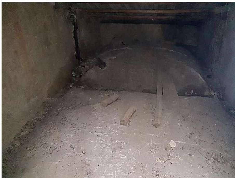
Figura II.16. Estradosso di due volte realine a padiglione a pianta quadrata da cui si evince lo strato di malta di gesso (foto dell'Autore).
