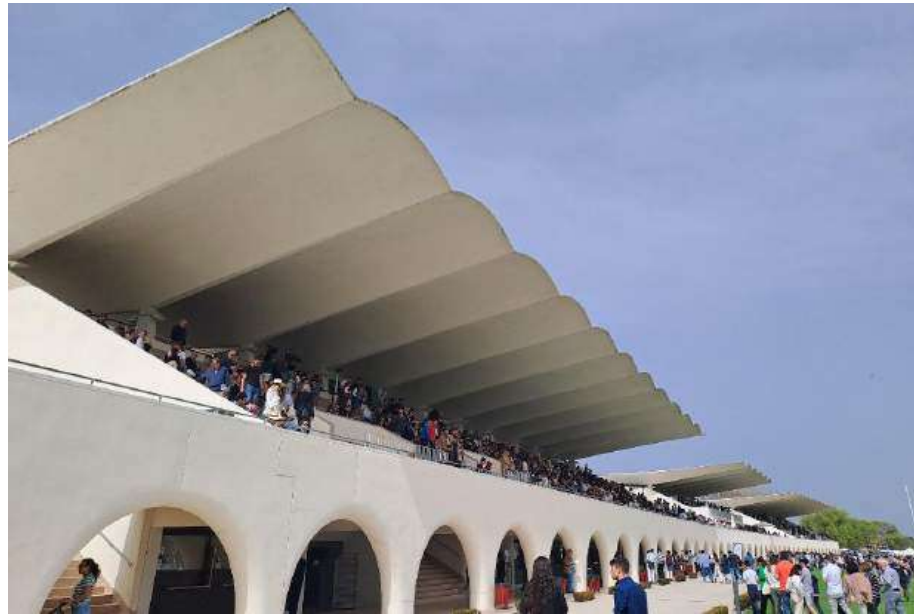
Figura II.36. Copertura a guscio degli spalti dell'Ippodromo della Zarzuela a Madrid (foto dell'Autore).
