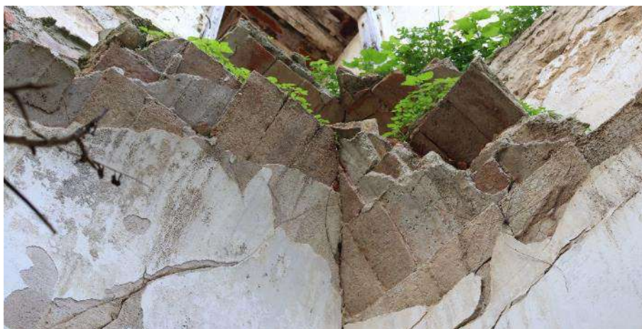
Figura III.10. Rovina di una volta realina da cui si evince la successione di strati di laterizi e di gesso (foto dell'Autore).
