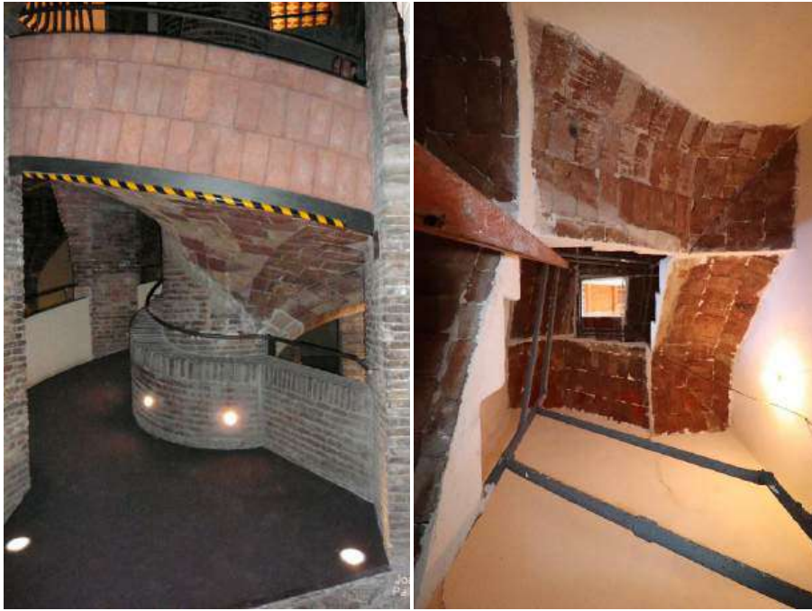
Figura II.10. Esempi di escalera tabicada (modernismobarcelona.com) e scala realina (foto dell'Autore).
