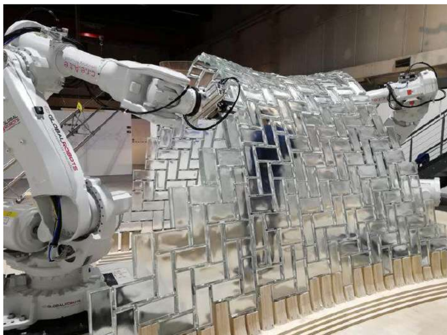
Figura II.66. Realizzazione del guscio in mattoni di vetro attraverso i bracci robotici (Paris et al., 2021).
