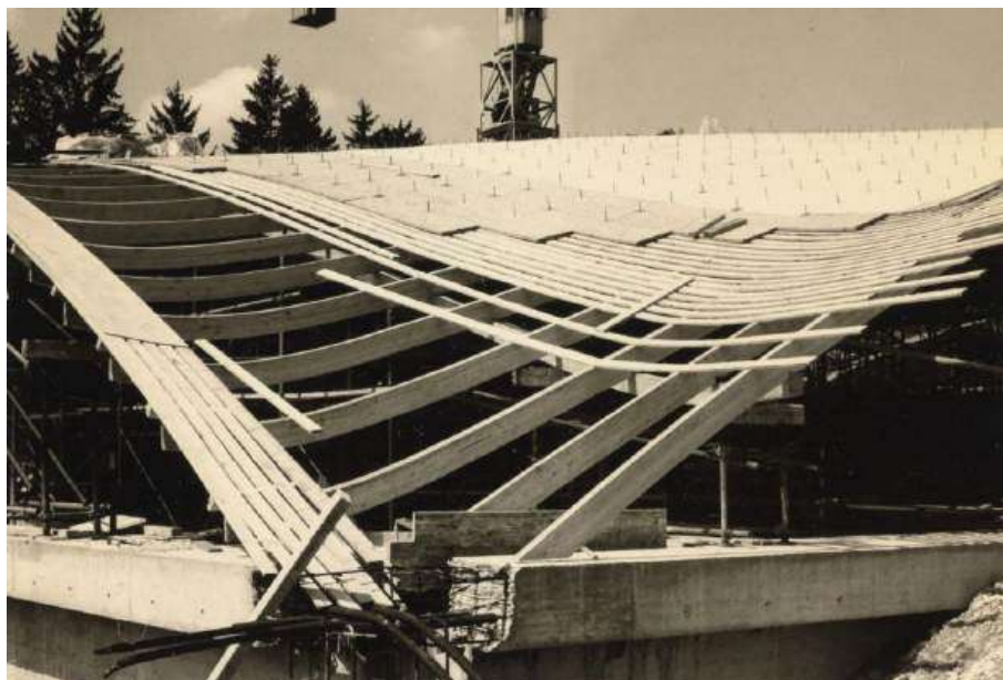
Figura IV.16. Impalcatura e sistema di centina-tura della Schwimmhalle ad Heimb-berg (gta Archiv/archi-vio Isler rif. 217_0370_F_4).
