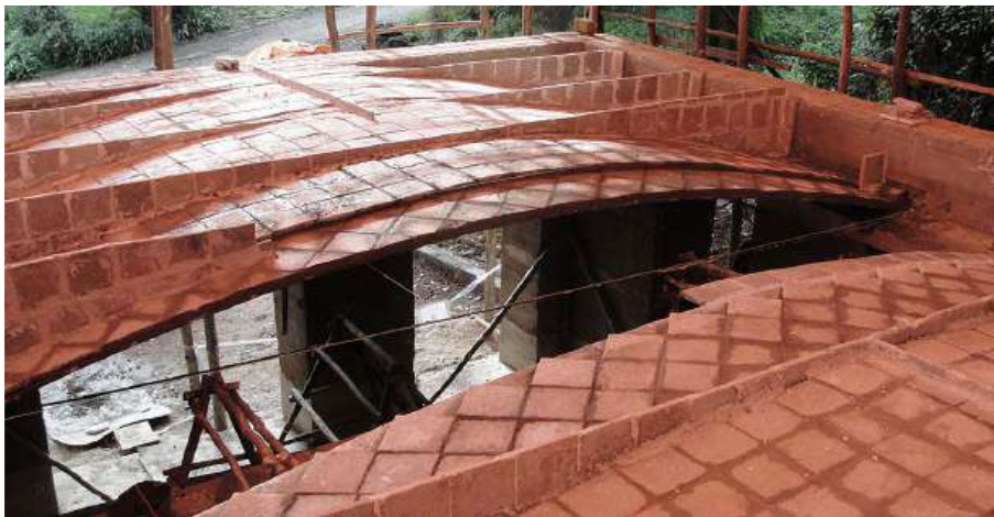
Figura II.65. Costruzione di una volta sottile in Etiopia (Block et al., 2010).
