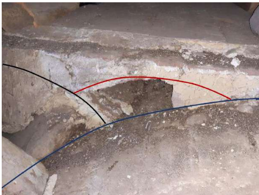
Figura III.16. Doppia controvoltina (in rosso), parzialmente murata, posta all'estradosso di una volta realina. In blu è evidenziata la volta realina e in nero la controvoltina (foto e rielaborazione grafica dell'Autore).
