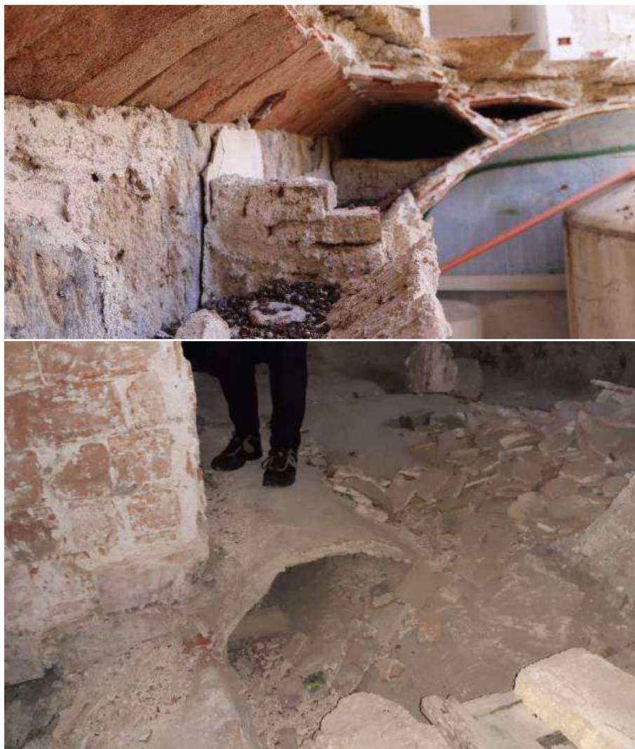
Figura III.14. Esempi di controvoltine (foto dell'Autore).
