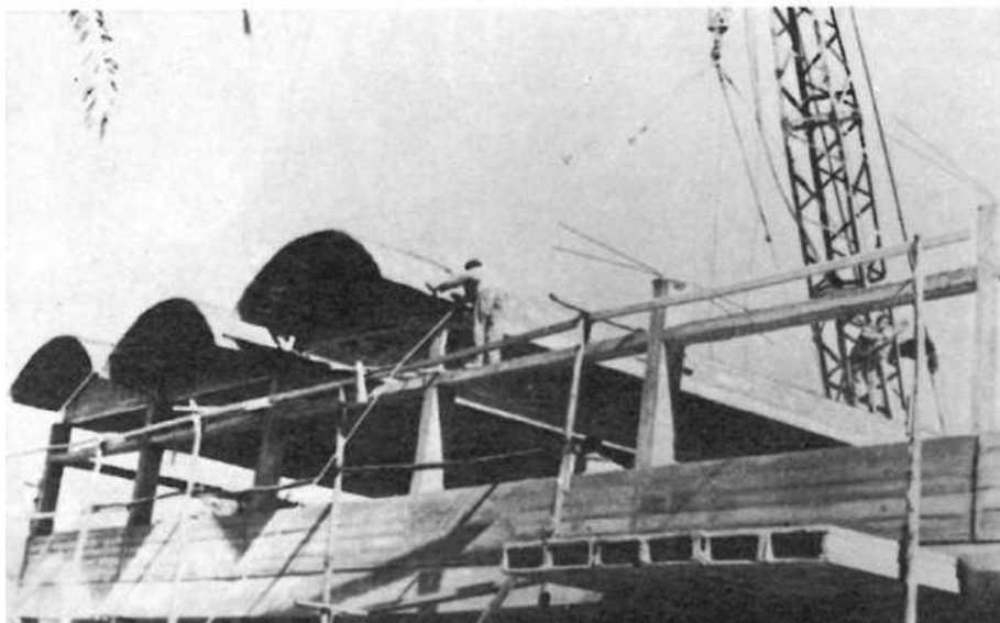
Figura II.54. Fasi di posa delle volte (Kalemkerian & Taroco, 1976).
