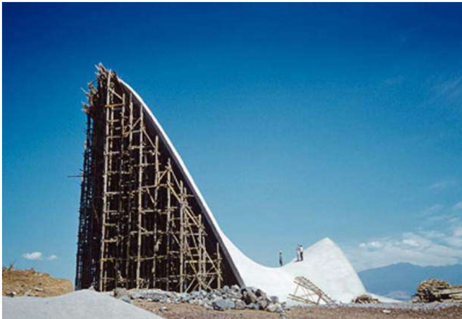
Figura II.41. Fasi costruttive della Cappella di Cuernavaca, in cui si può vedere l'impalcatura utilizzata e la forma finale del guscio ( https://www.architectuul.com/architecture/chapel-lomas-de-cuernavaca ).
