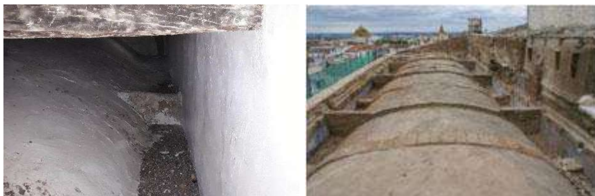
Figura II.17. Frenello in una volta realina (immagine dell'Autore) e muretes in una abobadilha portoghese (Rei et al., 2021).
