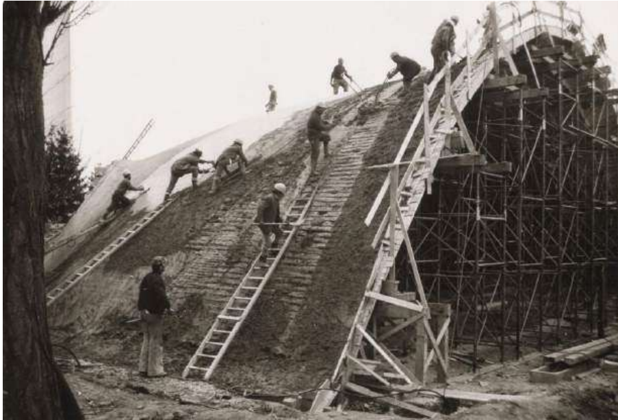
Figura IV.17. Ultimazione del getto di calcestruzzo nel guscio del Theater unter den Kuppeln a Stetten (gta Archiv/archivio Isler rif. 217_0329_F_3).
