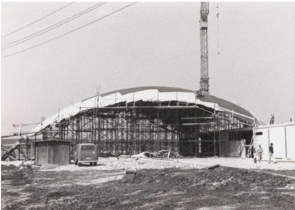
Figura IV.40. Fase di cassetatura del guscio (gta Archiv/archivio Isler rif. 217_0140_F_2).
