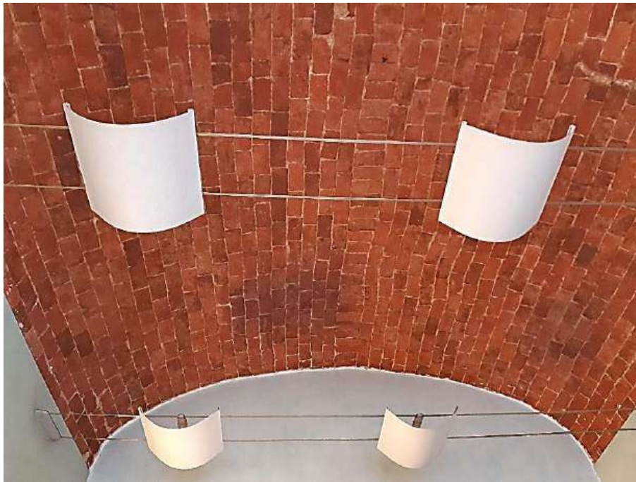
Figura III.21. Volta realina considerata per l'analisi strutturale (foto dell'Autore).
