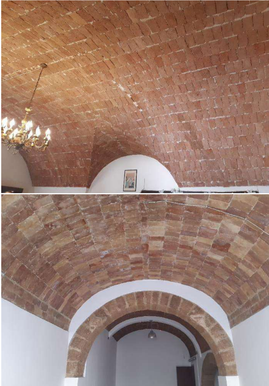
Figura III.9. Esempi di intradossi di volte realine in cui lo scrostamento dell'intonaco permette di apprezzarne la disposizione dei mattoni (foto dell'Autore).
