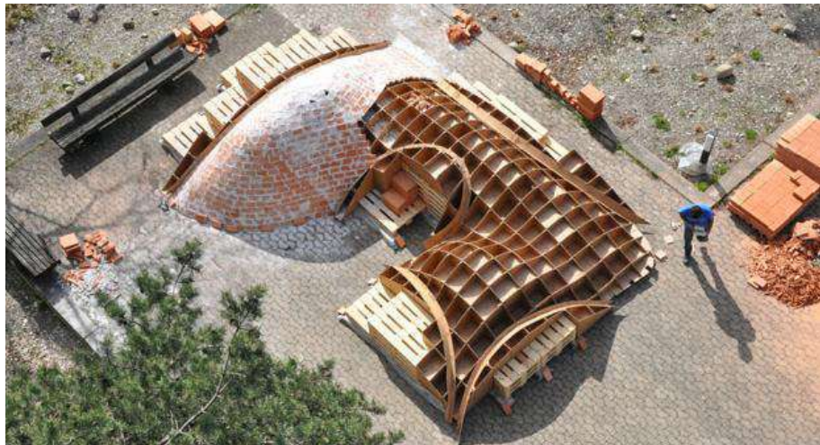
Figura II.61. Cassaforma in pallet e scatole di cartone utilizzata per il guscio (Davis et al., 2012).
