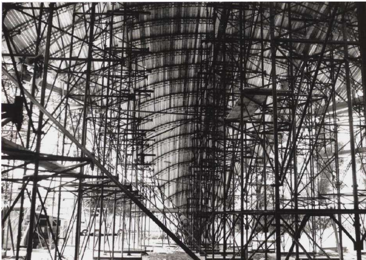
Figura IV.39. Impalcatura del guscio (gta Archiv/archivio Isler rif. 217_0140_F_1). Da questa prospettiva si comprende, oltre alla grande quantità di tubi d'acciaio usata per la centinatura, come le assi di legno poggino su dei tralicci curvi.
