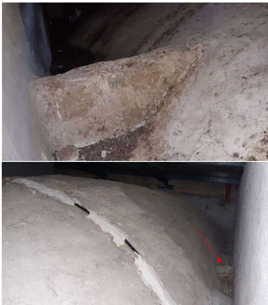
Figura III.13. Esempi di frenelli posti all'estradosso delle volte realine di due edifici ecclesiastici.
