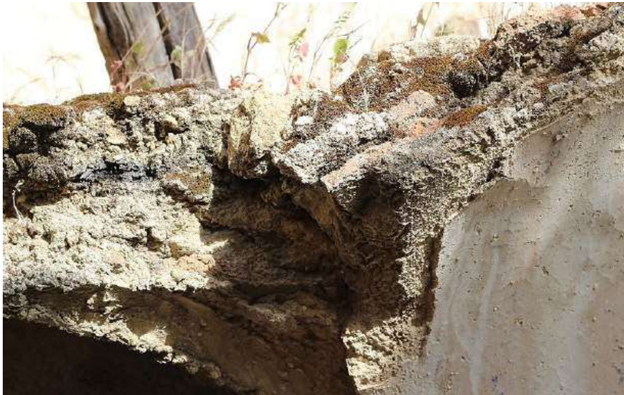
Figura III.12. Rinfianco dell'estradosso di una volta realina a sesto ribassato (foto dell'Autore).
