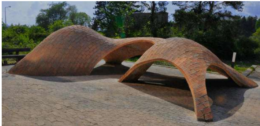
Figura II.60. Prototipo di guscio la cui forma è stata ottimizzata con la TNA ( https://brg.ethz.ch/research/prototypes/735 ).
