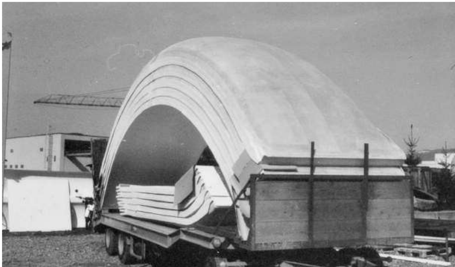
Figura IV.18. Gusci prefabbricati in poliestere rinforzato con fibre di vetro (Lykov, 2025).
