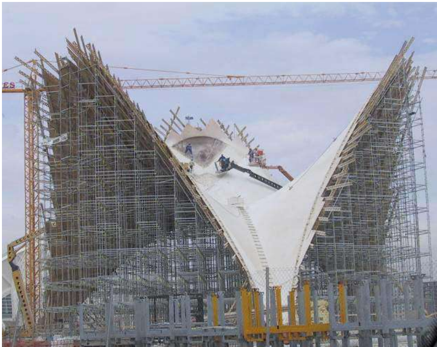
Figura II.44. Impalcatura utilizzata per la realizzazione del guscio de L'Oceanogràfic (Tomás & Martí, 2010).
