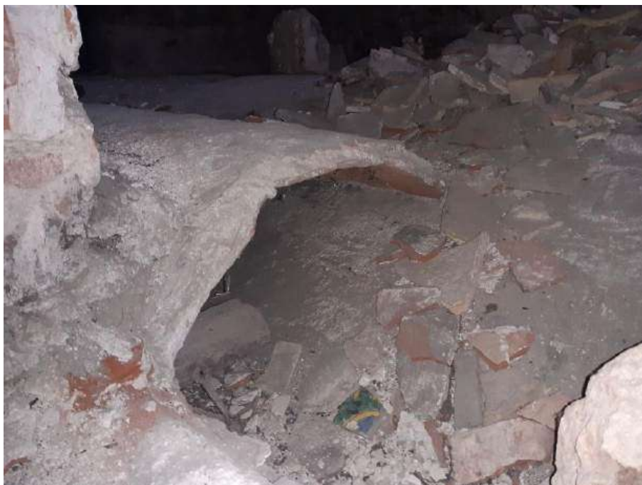
Figura II.20. Controvoltina all'estradosso di una volta realina (foto dell'Autore).
