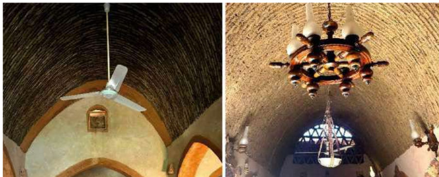
Figura II.8. Esempi di volte nubiane rinvenute in un villaggio nei pressi di Abu Simbel (Di Maggio et al., 2024).
