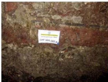
16. Roma, Ospedale S. Giovanni. Oratorio paleocristiano, parete perimetrale nord-orientale: posizionamento del duplice prelievo (intonaco e pellicola pittorica) nel medesimo settore eseguito sul dipinto murale (Delta A.P.S. Service s.r.l.)
