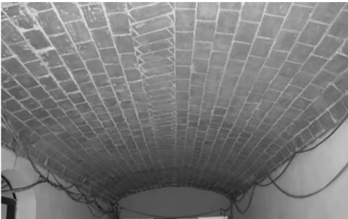
Fig. 7. Volta a botte realina, costruita intorno al 1860, presente a Palermo; da notare è la somiglianza del coronamento al sistema portoghese (Fatta et al., 2016).
