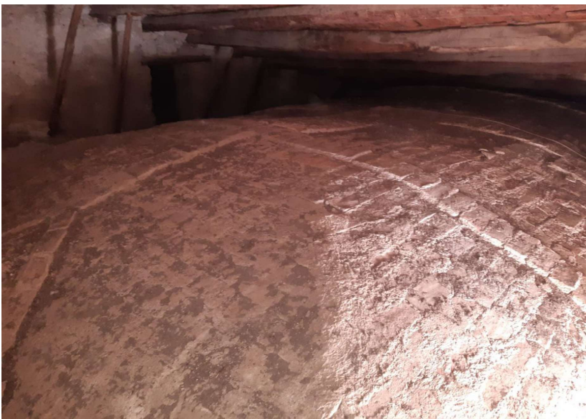
Fig. 9. Estradosso di una delle volte realine della chiesa di Maria SS. Annunziata (chiesa Madre) di Partinico; si nota, oltre alla cappa di malta di gesso che rende ancora visibile l'orditura dell'ultimo strato, la presenza di costolonature realizzate in corrispondenza delle zone più vulnerabili (foto di C. Di Maggio).
