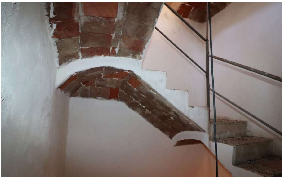
Fig. 10. Particolare dell'intradosso della scala a pozzo, costruita secondo la tecnica realina, di accesso al campanile della chiesa di Gesù e Maria a Partinico (foto di D. Giardina).
