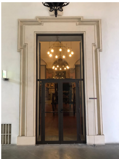
Fig.4 - Sala 6, vista dall'esterno
