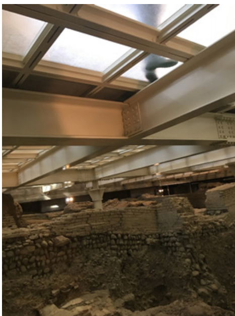
Fig. 4 - Il soffitto vetrato sopra gli scavi
