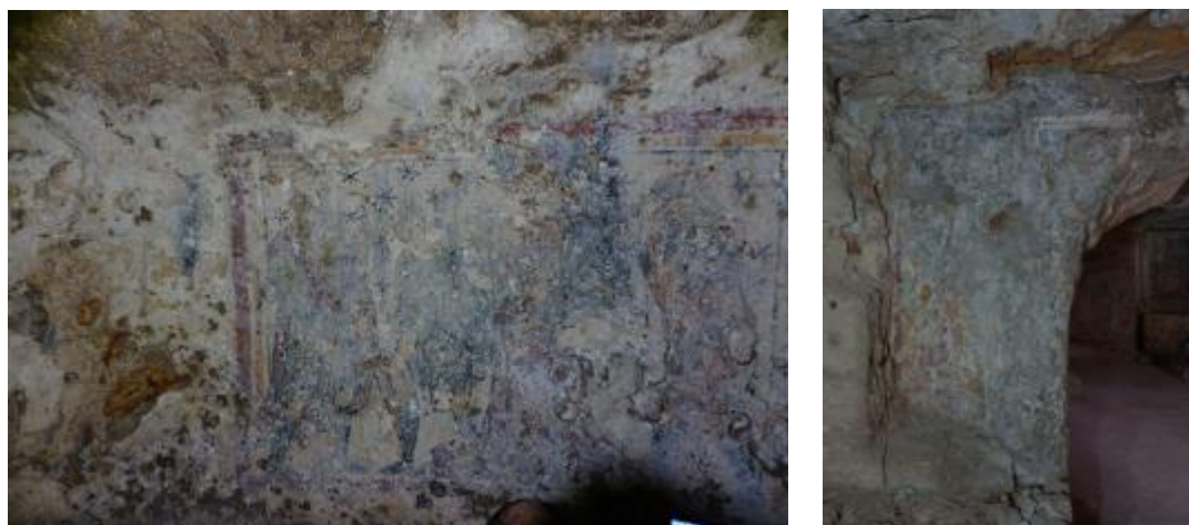
Fig. 3.6 Immagine in luce visibile degli affreschi Il Martirio di Santo Stefano (sinistra) e Odigitria e San Gabriele Arcangelo (destra), che mostra una diffusa patina salina concrezionata che ricopre la superficie pittorica e compromette significativamente la leggibilità della scena dipinta.
