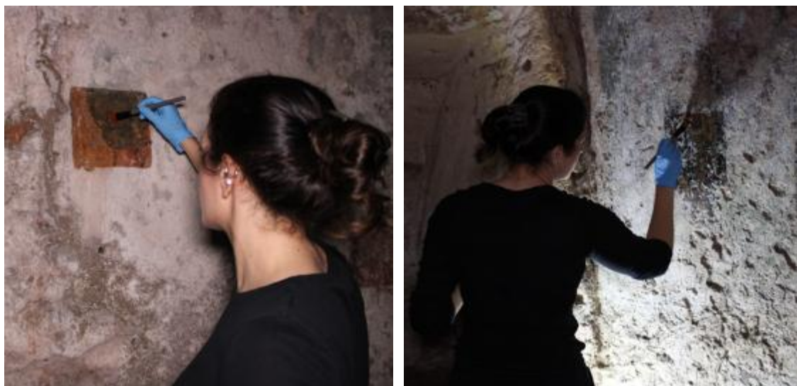
Fig. 3.32 Applicazione a pennello dei sistemi consolidanti su tasselli selezionati. A sinistra, l'affresco la Teoria dei Santi; a destra, l'affresco la Vergine e San Vito.
