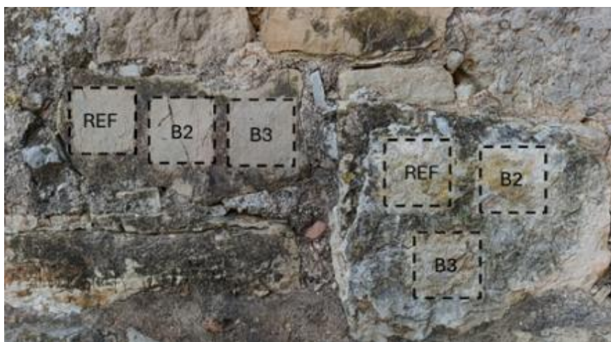
Fig. 5.20 Individuazione delle aree di prova sui due litotipi selezionati. Per ciascun substrato sono evidenziati il tassello di riferimento non trattato (REF) e le aree trattate con i sistemi B2 e B3.
