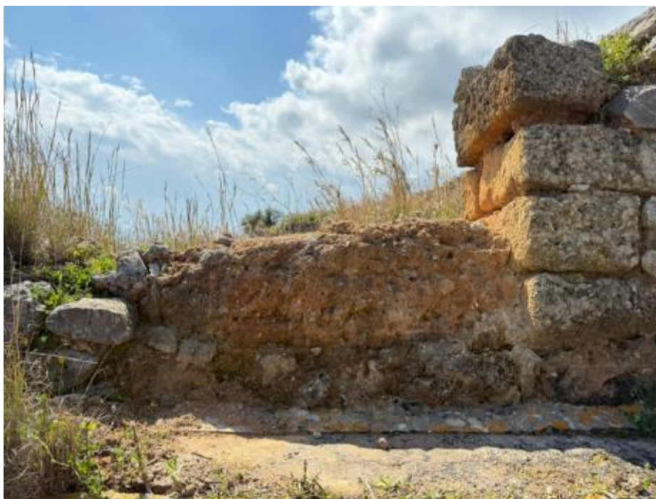
Fig. 4.13 Porzione muraria in terra cruda dell'Insula VIII/a (vano I, Solunto) oggetto delle applicazioni in situ dei sistemi consolidanti.
