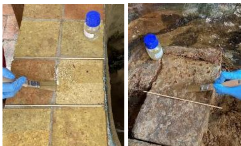
Fig. 5.13 Applicazione del sistema B1 a pennello sul bordo della vasca (sinistra); e sugli elementi scultorei all'interno della nicchia affrescata (destra).
