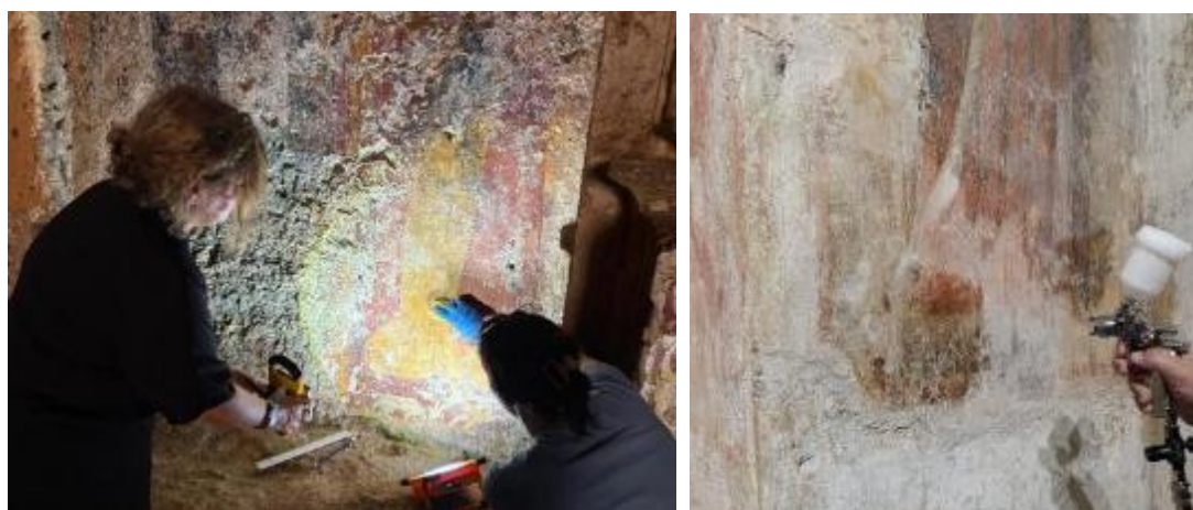
Fig. 3.45. Applicazioni in situ dei trattamenti consolidanti nell'ambito del progetto SAMOTHRACE, in collaborazione con lo spin-off Snaptech. A sinistra, fase operativa presso il Complesso Monumentale di Santa Maria della Grotta (Marsala); a destra, applicazione mediante aerografo presso la Chiesa ipogea di Sotterra.
