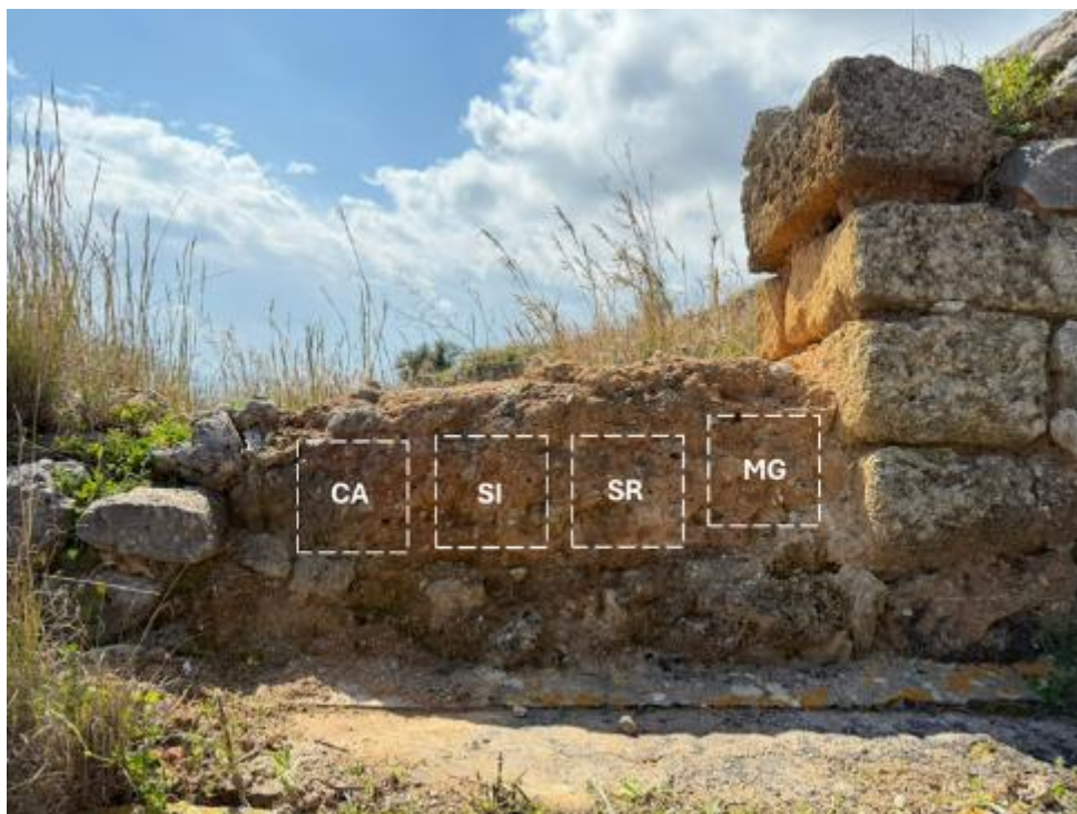
Fig. 4.14 Tasselli selezionati in cui sono stati applicati i sistemi consolidanti
