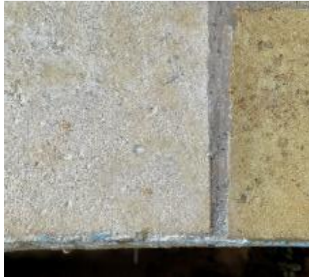
Fig. 5.14 Dettaglio della superficie in cotto del bordo della vasca dopo l'applicazione del sistema B1. È visibile una lieve patina superficiale biancastra, attribuibile all'eccesso di matrice silicea.
