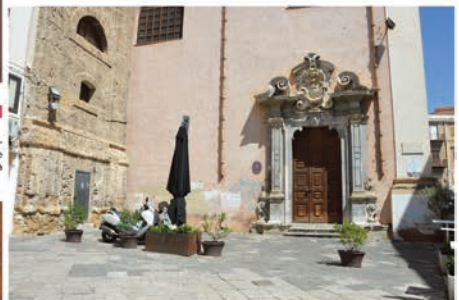
VISTA SU LARGO DEI CAVALIERI DI MALTA PRIMA DELL'INTERVENTO
