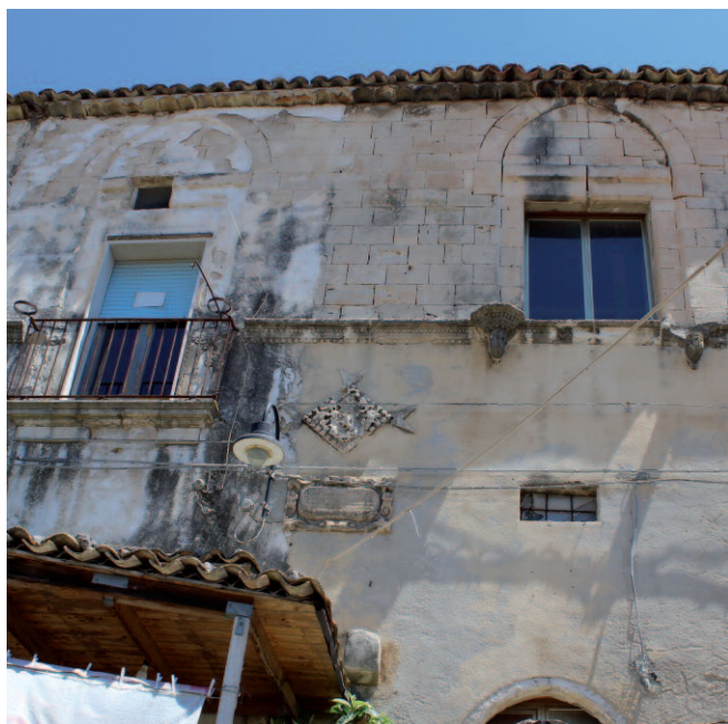
Fig. 12. Scicli. Palazzo Terranova Cannariati, facciata principale.
