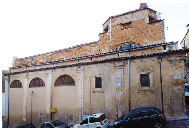
Fig. 1. Ciminna. Chiesa di San Francesco d'Assisi, prospetto laterale.
