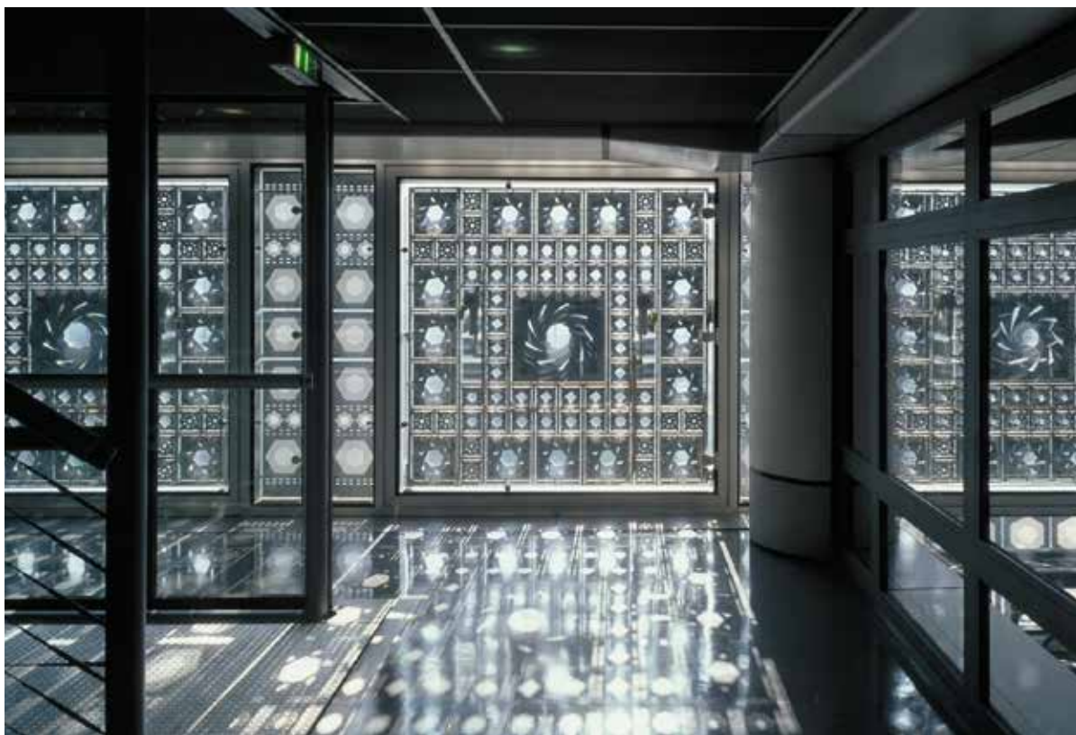
Fig. 2. Institut du monde arabe, J.Nouvel, 1987, Parigi. Vista interna dei pannelli mobili semi-aperti
