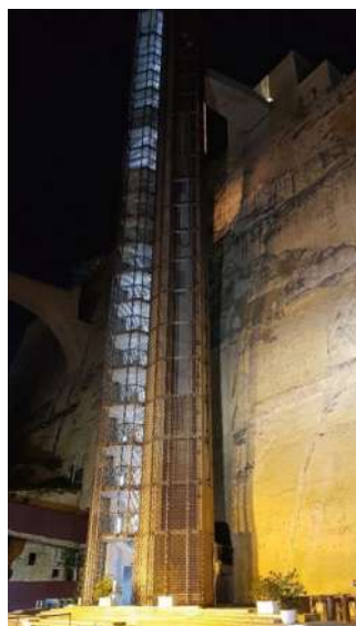
Fig. 6 - Ascensore urbano per superare il dislivello tra il porto e la città storica a Malta. (Foto dell'Arch. Renata Prescia.)
