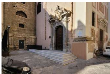
Fig. 1 - Palermo, Chiesa di Santa Maria in Valverde: la rampa per disabili che si innesta sul nuovo sagrato, il quale evoca il livello originario del piano del Largo Cavalieri di Malta. (Foto dell'Arch. Renata Prescia.)
