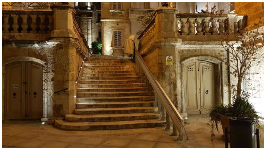
Fig. 3 - Un servo-scala per superare un dislivello nell'isola di Malta. (Foto dell'Arch. Renata Prescia.)
