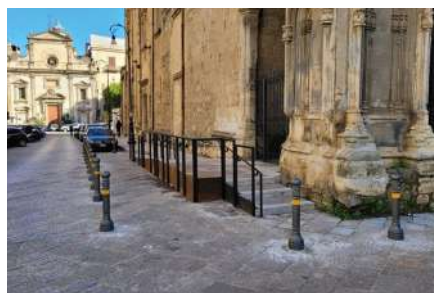
Fig. 2 - Palermo, Chiesa di Santa Maria La Nova: la nuova rampa di accesso al sagrato della chiesa. Accanto il percorso protetto dai dissuasori per i pedoni, voluto dall'amministrazione comunale. (Foto dell'Arch. Renata Prescia.)
