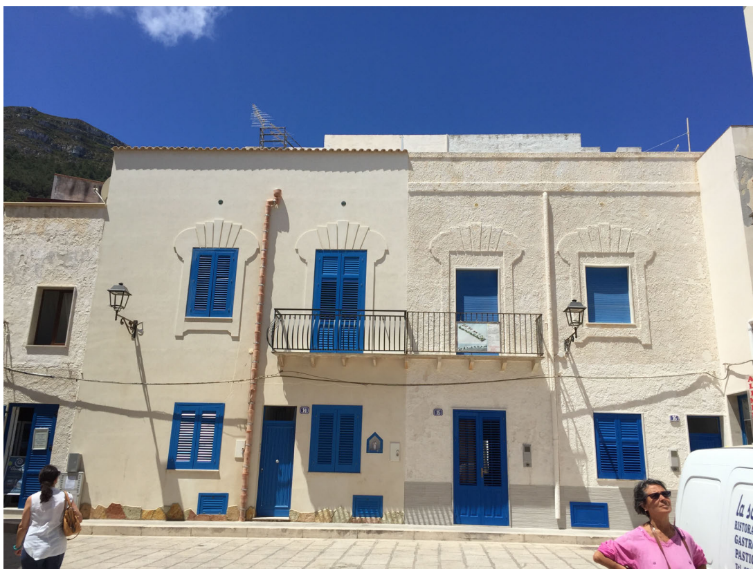
Figura 10 | Marettimo. Edificio in stile Déco. Gli interventi di manutenzione della facciata ne hanno alterato i colori originari (utilizzo del bianco per la muratura e dell'azzurro per gli infissi); la divisione proprietaria dell'edificio ha condotto a rimaneggiamenti differenti che non hanno rispettato l'unità di facciata.
