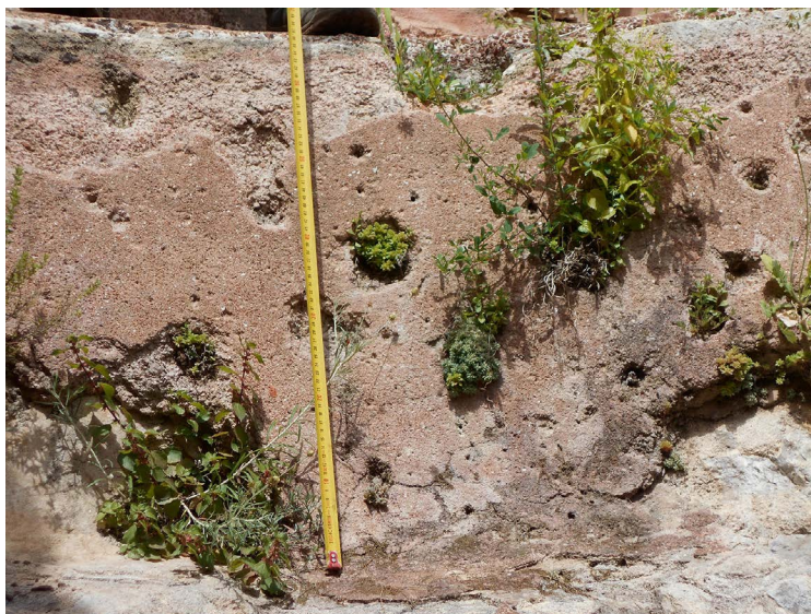
Figure 9. Traces de l'explosion sur les parois de la citerne Cliché G. Polizzi
