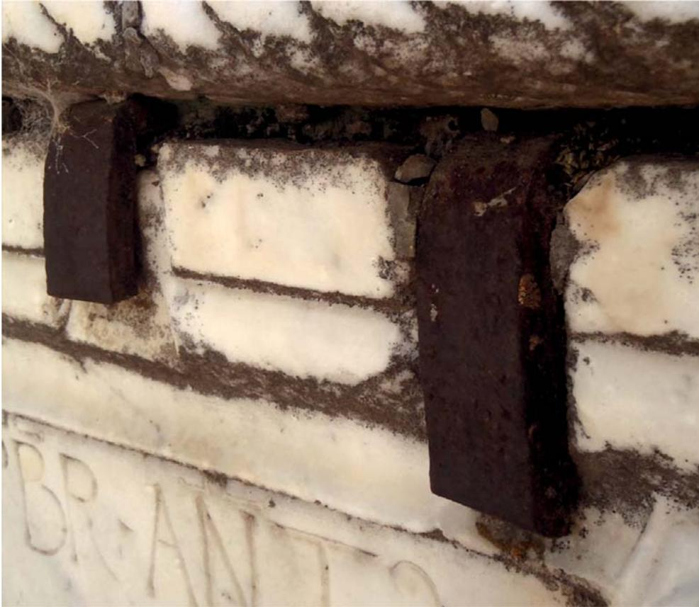
**Fig. 19** Due delle tre zanche metalliche poste a contenere le eventuali spinte dell'architrave ricollocata.
