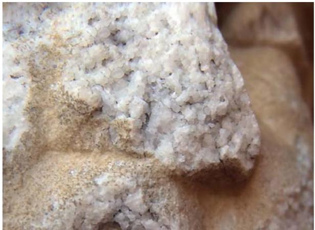
**Fig. 9** Decoesione intergranulare che porta alla perdita di significativi dettagli scultorei.
