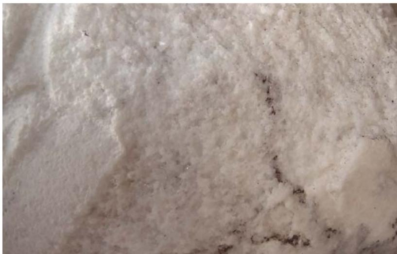
**Fig. 13** Impacco con consolidante inorganico-minerale e dettagli dell'esito positivo del trattamento.
