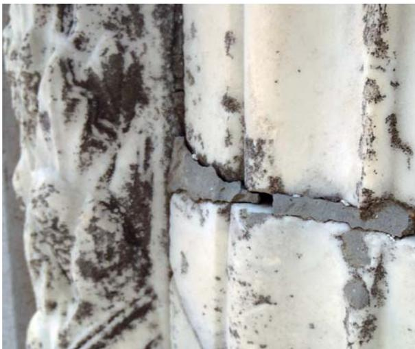
**Fig. 22** Rimozione meccanica di precisione delle stuccature eseguite con malte cementizie.
