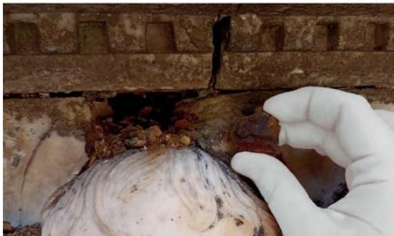
**Fig. 20** Sequenza che mostra come il distacco di scaglie sia dovuto alla presenza di stiffe metalliche, il cui volume è aumentato per via della loro ossidazione.
