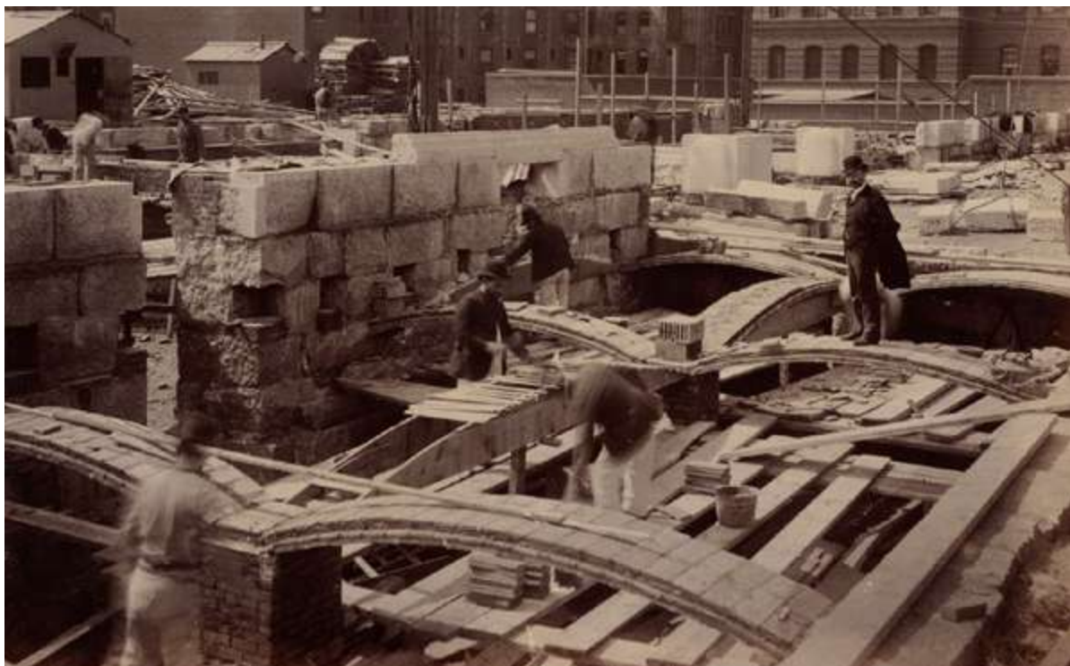
Fig. 2. Rafael Guastavino, a destra, sopra uno dei costoloni delle volte catalane del Mc Kim Building a Boston (1895).
