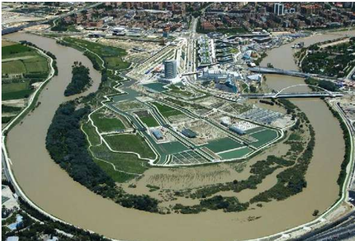
Fig.3: Parque del Agua, foto aerea, Saragozza. (Foto:©Jordi Bernadó /Santiago Amo, 2008). Fonte: www.arquitecturaviva.com
