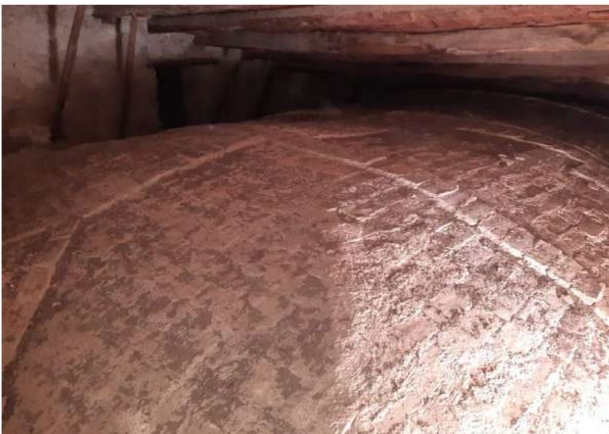
Fig. 9. Estradosso di una delle volte realine della chiesa di Maria SS. Annunziata (chiesa Madre) di Partinico; si nota, oltre alla cappa di malta di gesso che rende ancora visibile l'orditura dell'ultimo strato, la presenza di costolature realizzate in corrispondenza delle zone più vulnerabili (foto di C. Di Maggio).
