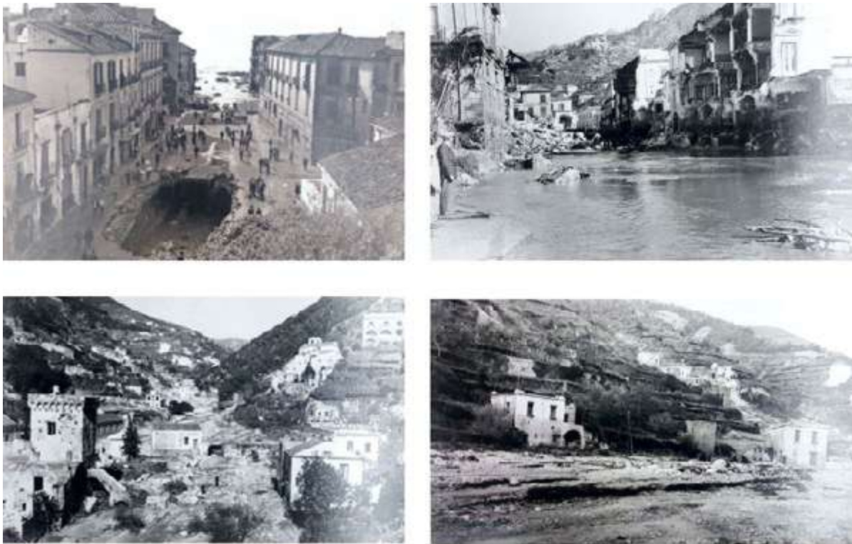
Fig. 10. a) Maiori, Corso Regina, 1954, cedimento della copertura in pietra calcarea del vecchio alveo; b) Maiori, Corso Regina, 1954, vista dal lungomare; c) Località Vecite, 1954, i danni dell'alluvione; d) Località Ponteprimario, 1954 .
