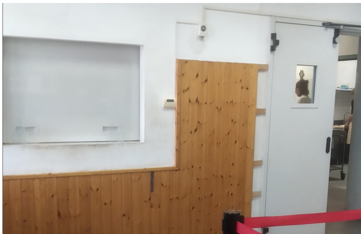
Fig. 2: Finestra passavivande, qui ancora chiusa, mensa Santa Caterina (foto Antonio Cetani)
