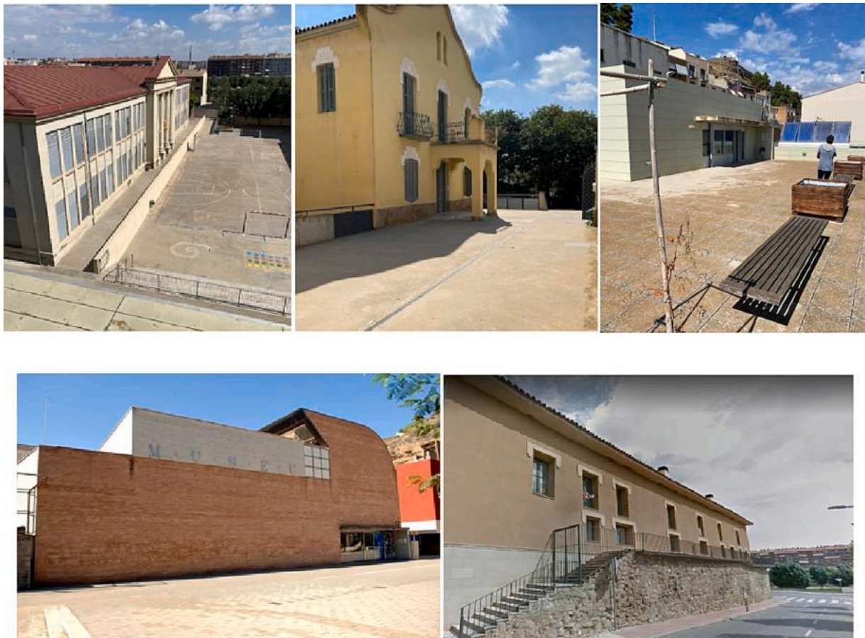
Fig. 3. Main façades of the buildings. (a) Àngel Guimerà Public School, (b) Xalet Montiu, (c) Servei Educatiu de la Noguera, (d) Museu de la Noguera, and (e) Biblioteca Margarida de Montferrat.
