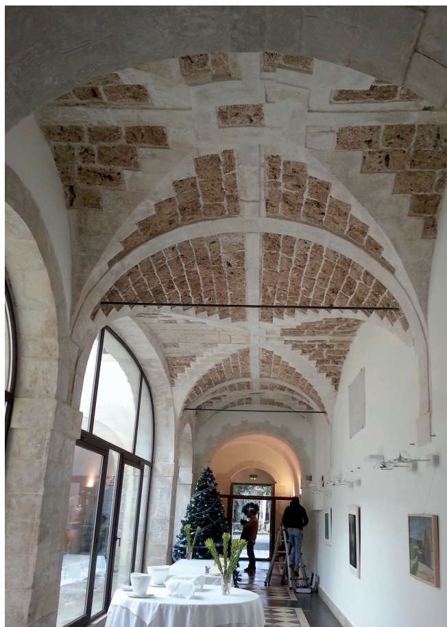
Fig. 7. Ragusa. Convento dei Cappuccini, volte del corridoio di accesso al chiostro (primi anni del XVII secolo).
