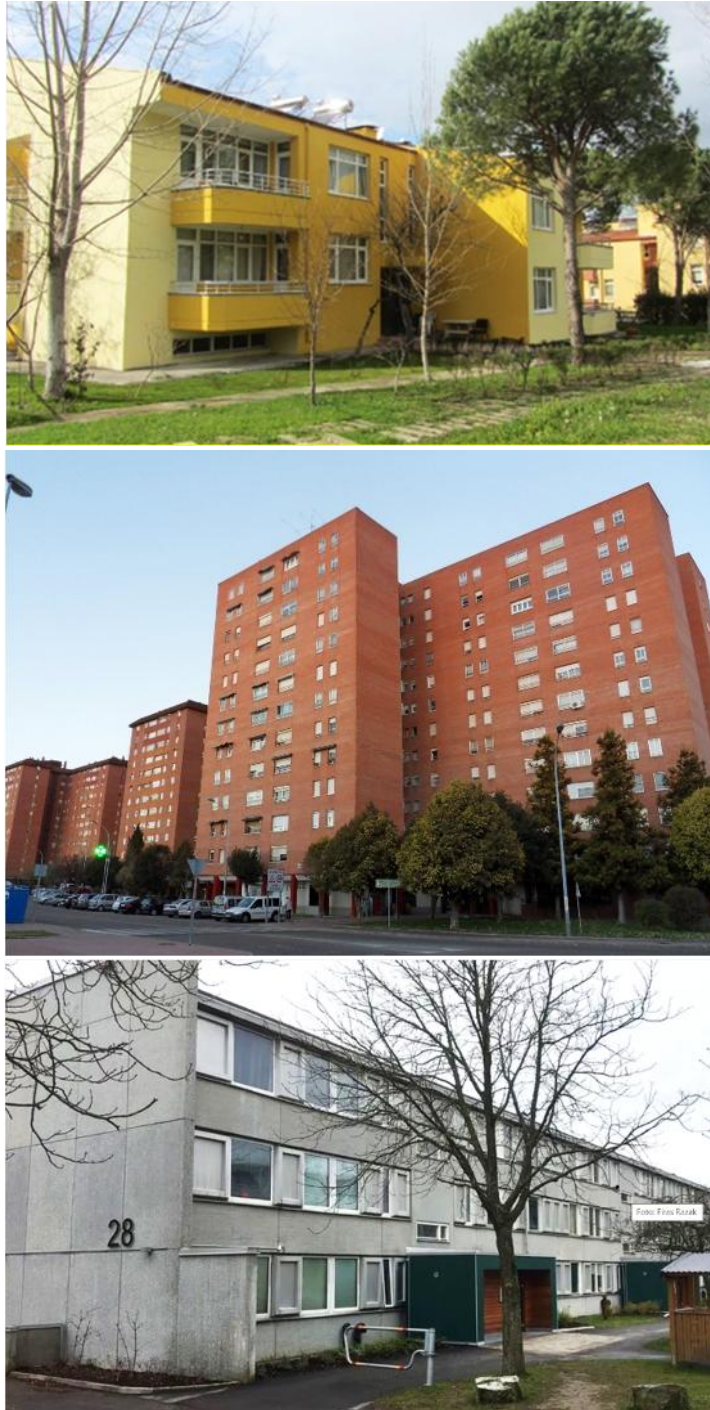
Figura 2.8. Edifici tipo (ante intervento) dei siti dimostrativi di Soma (in alto), Laguna de Duero (in mezzo) e Lund (in basso) (fonte: www.cityfied.eu )
