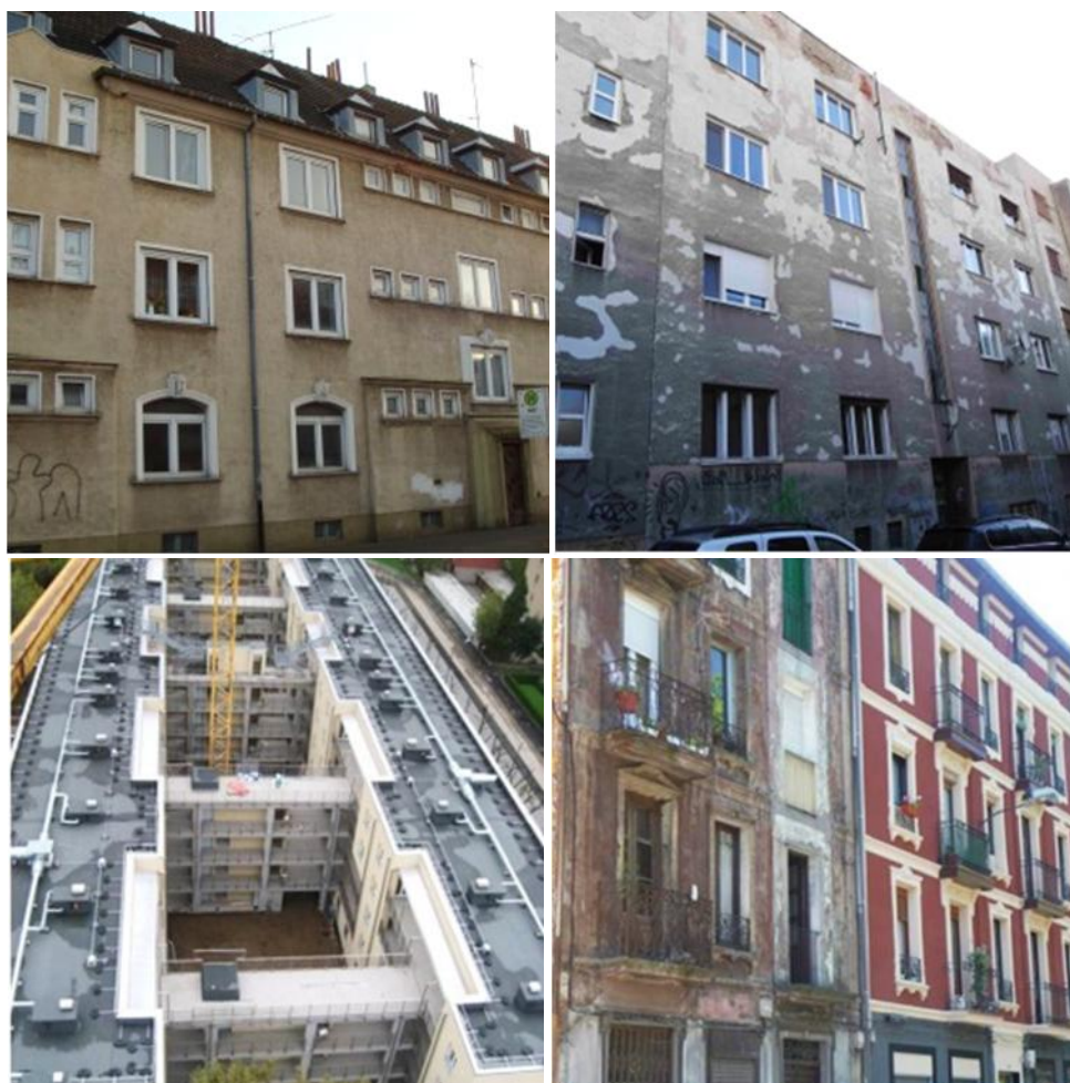
Figura 2.5a. Edifici tipo (ante interventi) dei siti dimostrativi di Aquisgrana (in alto a sinistra) e Bratislava (in alto a destra), Milano (in basso a sinistra), Sestao (in basso a destra)
