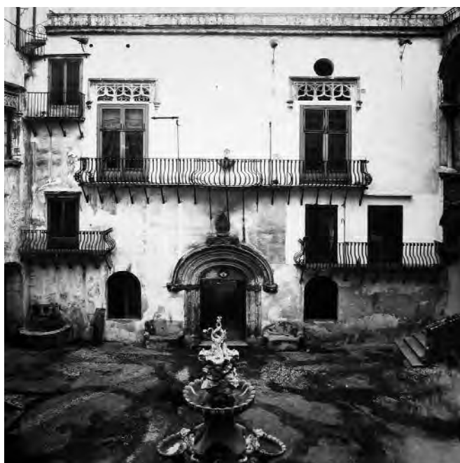
Fig. 2. Palermo. Palazzo Abatellis, prospetto sud-est della corte prima del restauro. Il progetto comporterà lo smontaggio dei balconi, lo scrostamento degli intonaci e la chiusura delle aperture sei-settecentesche e lo spostamento delle fontane (Archivio fotografico SBBCCAAP).
