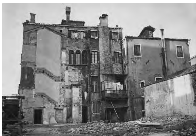
Fig. 10-11. Venezia. Palazzo Adoldo, le opere di messa in sicurezza della facciata e la demolizione del corpo aggiunto (IUAV, AP, FFT, Forlati 2.1 Progetti e concorsi/045).
