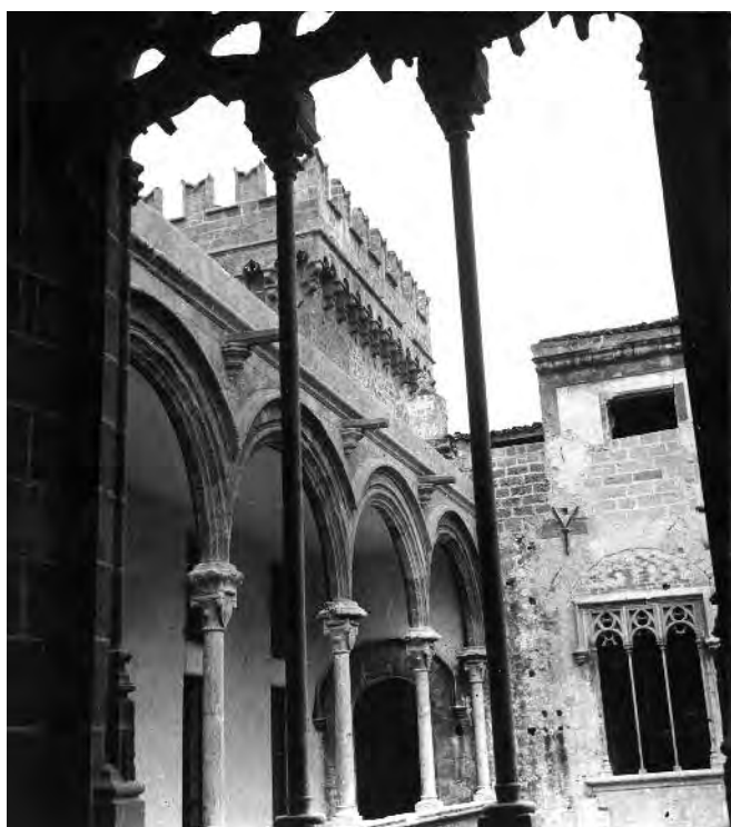
Fig. 22. Palermo. Palazzo Abatellis, una fase del cantiere in cui erano già state completate la ricostruzione dell'ala sud-ovest e della torre merlata (MBACT, ICCD - Archivio MPI, fondo P).
