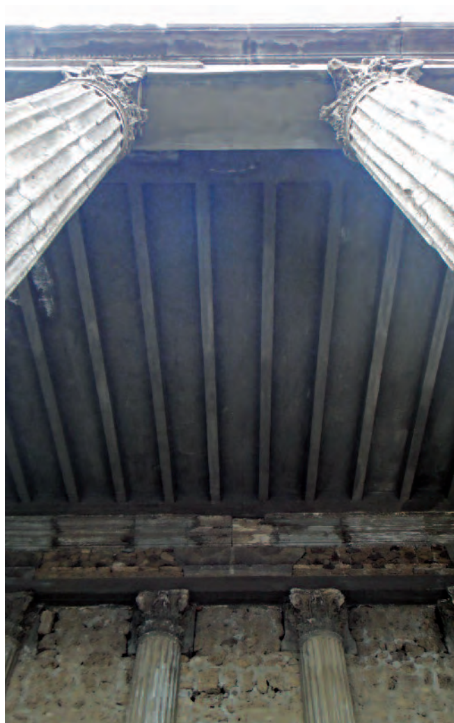
Fig. 4. Pompei. Tribunal della Basilica, ricostruzione per anastilosi con integrazioni in cemento armato (Foto 2023).
