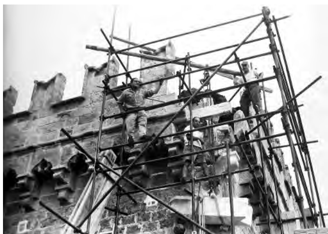
Fig. 16. Palermo. Palazzo Abatellis, ricostruzione della torre merlata (Archivio fotografico SBBCCAAP).
