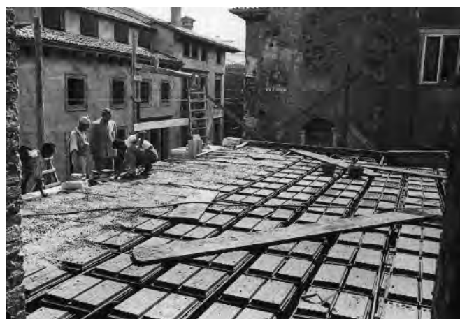
Fig. 5. Vicenza. Palazzo da Schio (Ca' d'Oro), la ricostruzione dei solai in laterocemento durante i lavori di restauro, 1945 post (IUAV, AP, FFT, 7.1319).
