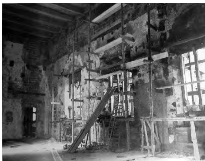
Fig. 18. Palermo. Palazzo Abatellis, una fase del cantiere di restauro al primo piano (Archivio fotografico SBBCCAAP).
