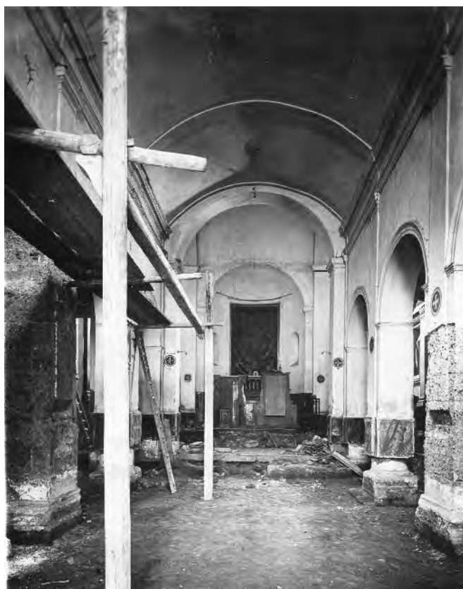
Fig. 3. Civita Castellana (Viterbo). L'interno di San Gregorio Magno in una foto del 1934. Si osservano le prime operazioni di rimozione della pavimentazione e degli intonaci in corrispondenza dei pilastri (su concessione della Soprintendenza Belle Arti e Paesaggio per le province di Roma, Frosinone, Latina, Rieti e Viterbo, numero di negativo 3932, anno 1934).
