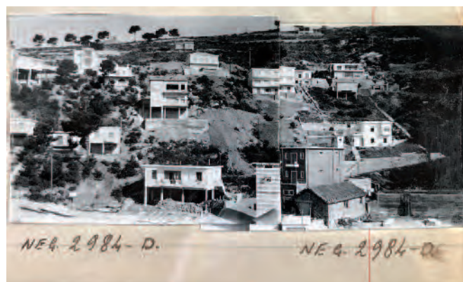
Fig. 5. A. Dillon, Quaderno dei sopralluoghi 1958-1960, Andora, Savona, Riviera di Ponente, dettaglio delle nuove costruzioni del cosiddetto "villaggio orizzontale" (Archivio Dillon).
