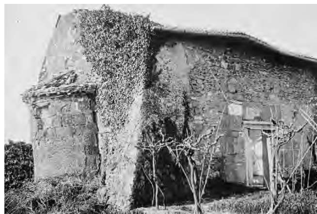
Fig. 13. Palestrina (Roma). San Giovanni Battista, l'inclinazione dell'abside osservata nel 1928, prima dei restauri dell'anno successivo (ACS, Ministero Pubblica Istruzione, Direzione Generale Antichità e Belle Arti, Divisione II, 1929-1932, b. 202, fasc. Roma - prov. P.T.).
