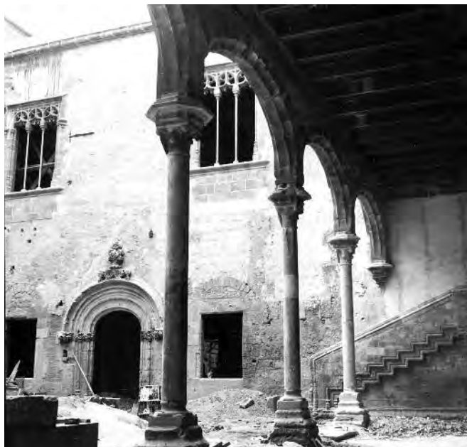
Fig. 21. Palermo. Palazzo Abatellis, una fase del cantiere in cui erano già state completate tutte le operazioni di liberazione e di ricostruzione del prospetto sud-est, del loggiato e del parapetto dello scalone esterno (MBACT, ICCD - Archivio MPI, fondo P).
