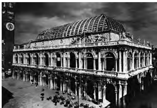
Fig. 4. Vicenza. Basilica Palladiana, ricostruzione con strutture in c.a. della copertura a carena di nave (IUAV, AP, FFT, 7.1264).
