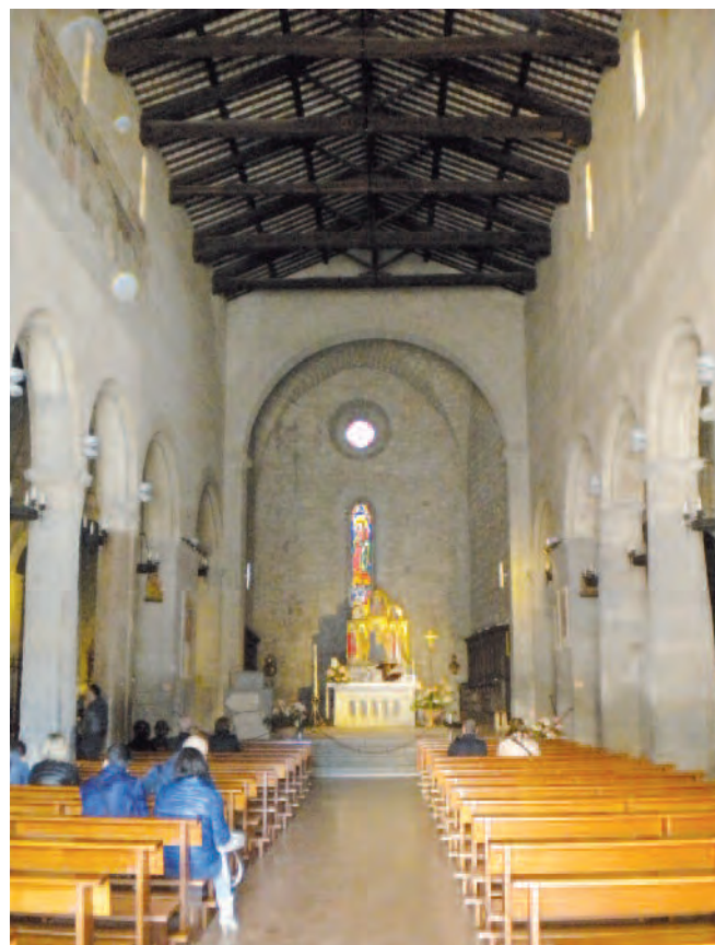
Fig. 2. Bolsena (Viterbo). Veduta odierna dell’interno di Santa Cristina. La chiesa appare oggi spogliata dei rivestimenti settecenteschi e l’arco trionfale fu interamente ricostruito in occasione del restauro novecentesco (da Donatelli, 2017).
