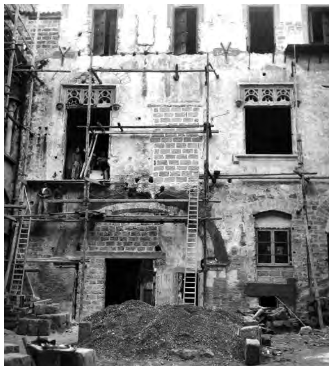
Fig. 19. Palermo. Palazzo Abatellis, una fase del cantiere di restauro del prospetto nord sulla corte (MBACT, ICCD - Archivio MPI, fondo P).
