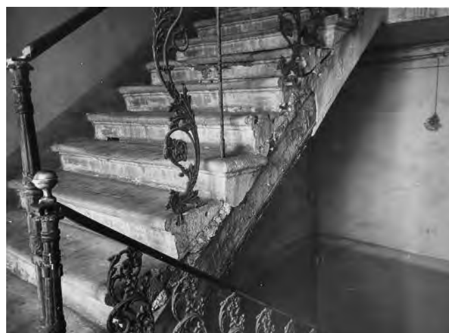
Fig. 8-9. Venezia. Palazzo Adoldo, gli interni prima dell'intervento di restauro (IUAV, AP, FFT, Forlati 2.1 Progetti e concorsi/045).
