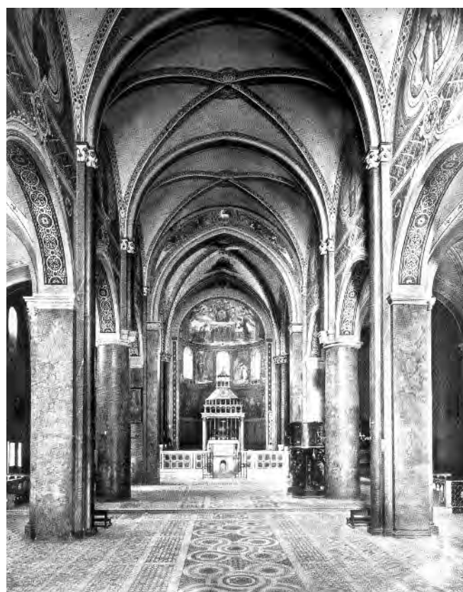
Fig. 4. Anagni (Frosinone). Cattedrale di Santa Maria, veduta interna prima del restauro novecentesco; si notano le volte a crociera realizzate sotto il vescovato di Antonio Seneca (Archivio Fratelli Alinari, n. 18689, 1915-1920 - da Palandri 2006, p. 217).
