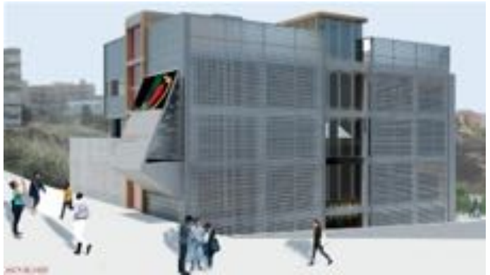
> Construction inachevée et hypothèse d'achèvement (thèse Projet d'achèvement de la structure inachevée abritant l'ancien tribunal de première instance d'Aragona par F. Vella, 2017).
